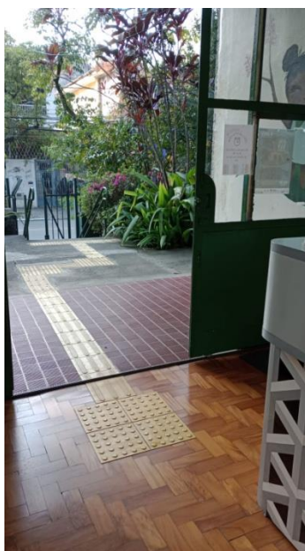
Figura 10 - Piso tátil na Biblioteca Raul Bopp.
