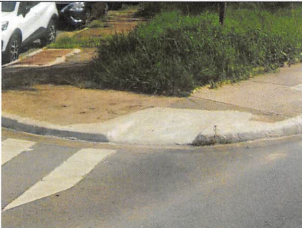
FOTO 05 – ESPAÇO A SER REVITALIZADO
