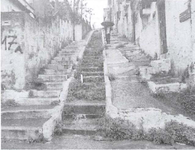
FOTO 01 – ESCADARIA A REFORMAR
