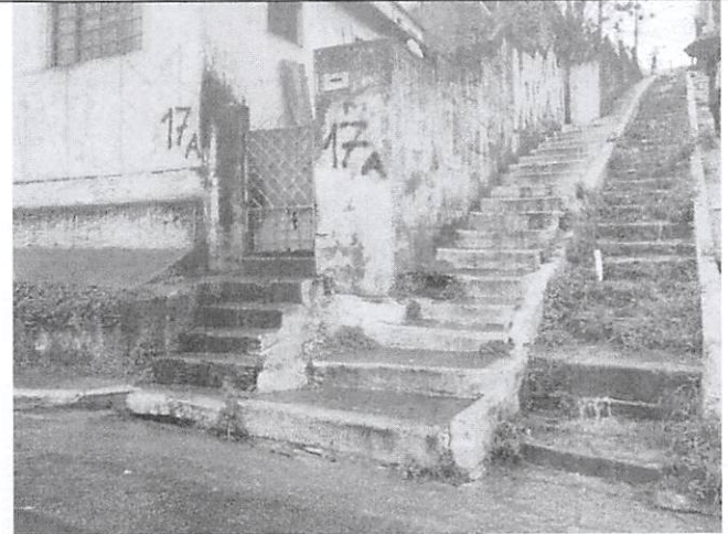
FOTO 04 – ESCADARIA A REFORMAR
