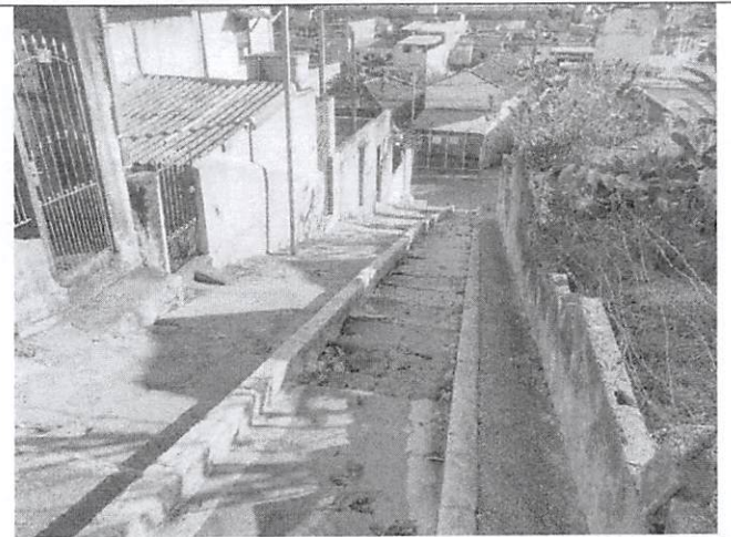
FOTO 06 – ESCADARIA A REFORMAR
