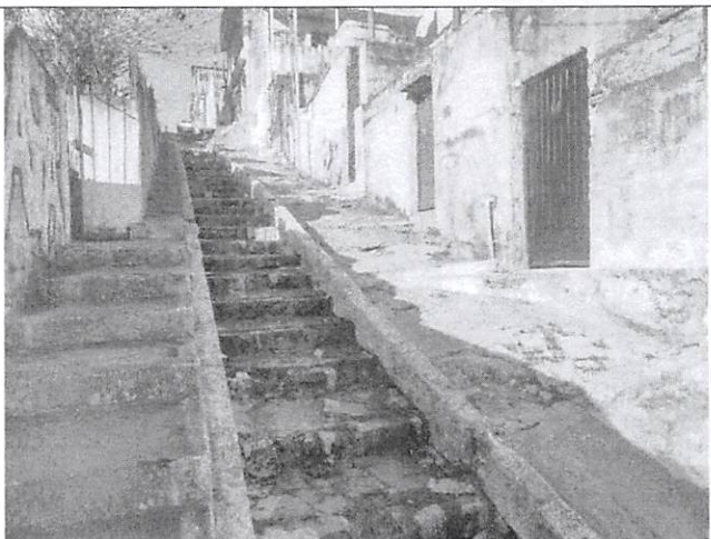
FOTO 05 – ESCADARIA A REFORMAR
