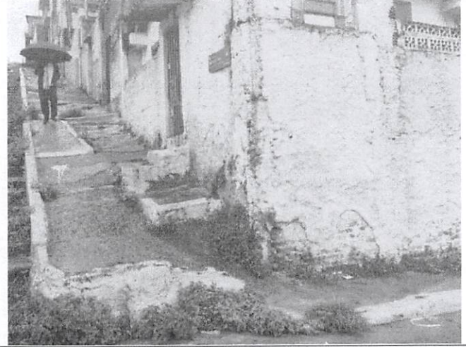
FOTO 02 – ESCADARIA A REFORMAR
