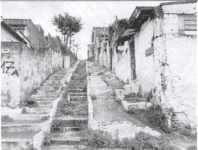
FOTO 03 – ESCADARIA A REFORMAR
