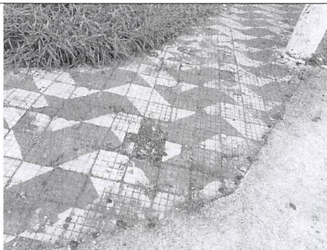
FOTO 07 – ESPAÇO A SER REVITALIZADO
