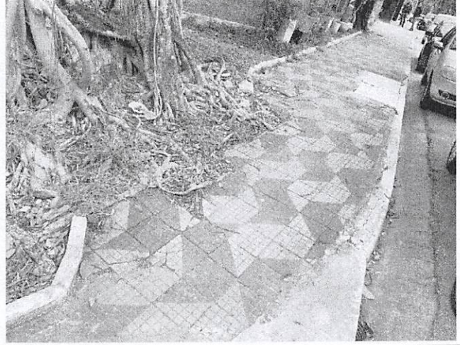
FOTO 02 – ESPAÇO A SER REVITALIZADO
