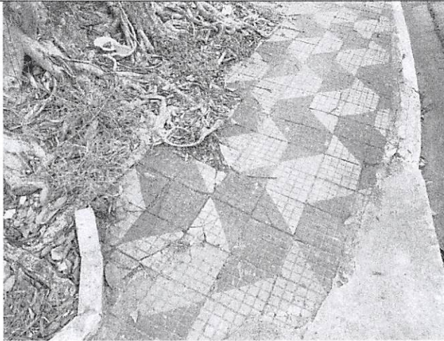
FOTO 03 – ESPAÇO A SER REVITALIZADO
