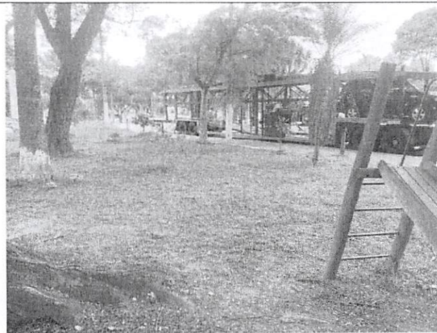
FOTO 11 – ESPAÇO A SER REVITALIZADO
