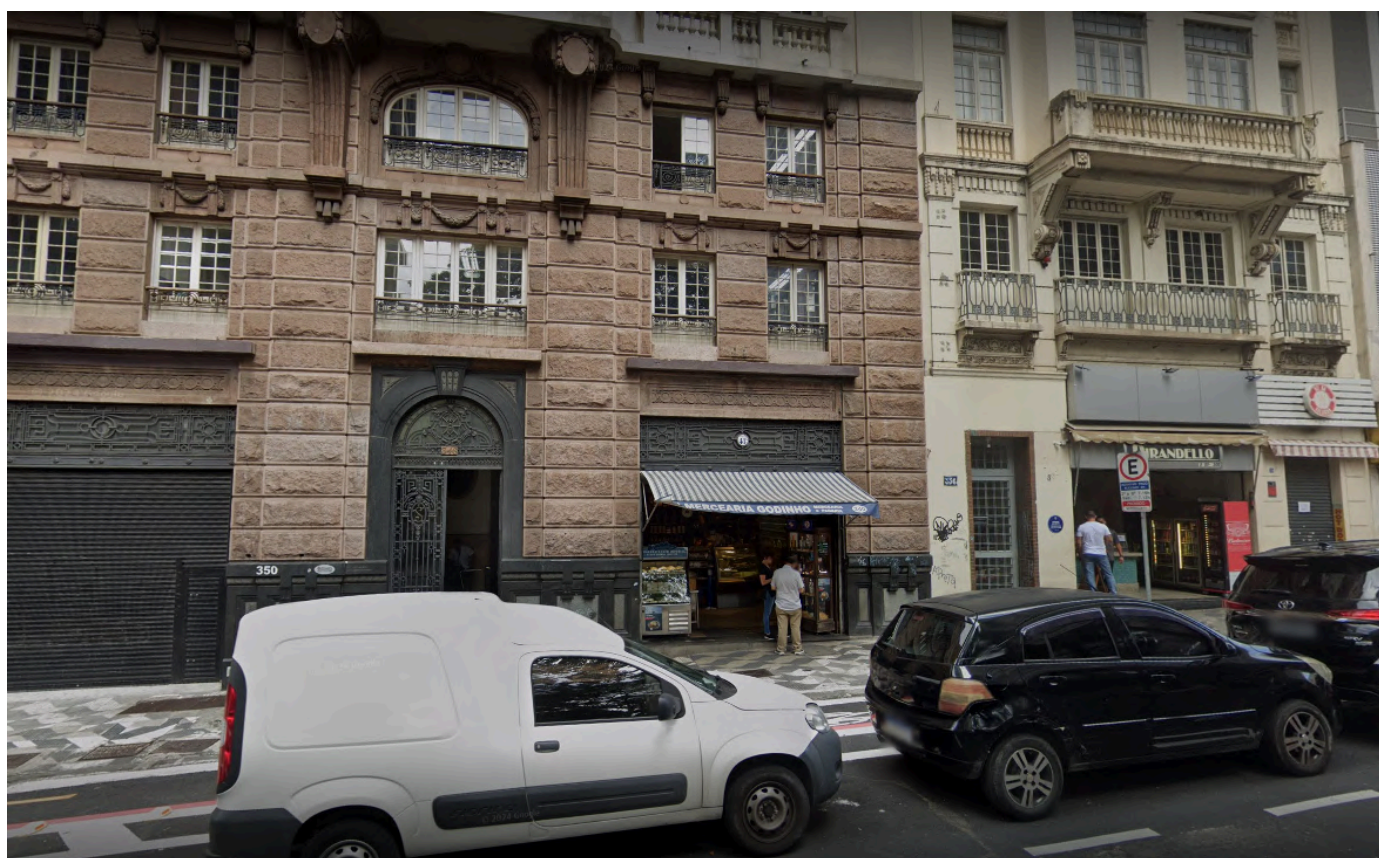
Fachada da Casa Godinho . Google Street View, 2025. Acesso em: 20 de janeiro de 2025.
