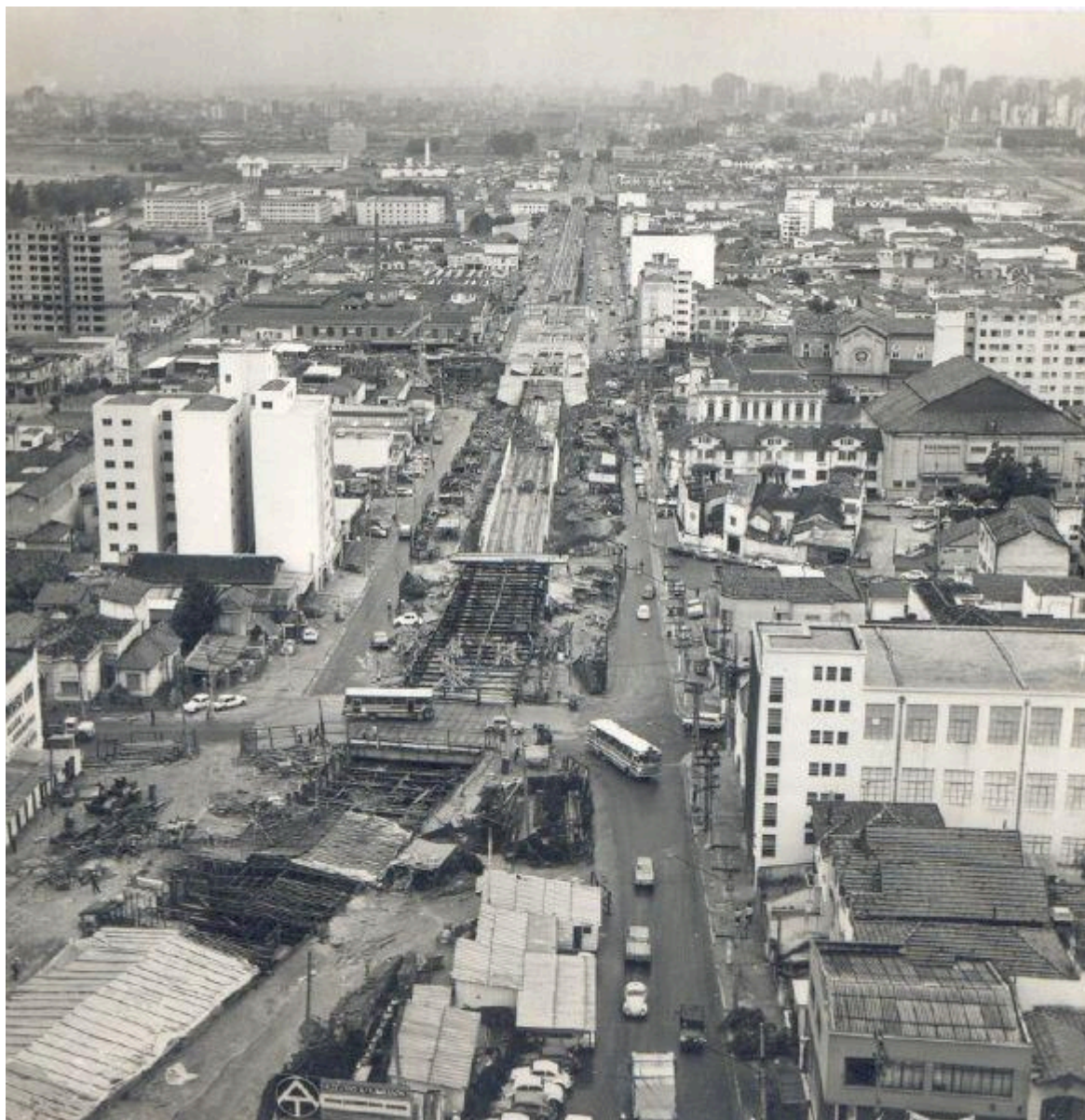
Obras civis Trecho 1 - Estações: Santana, Carandiru, Portuguesa-Tietê e Ponte Pequena. Fonte: Companhia Metropolitana do Metrô de São Paulo - METRÔ, 31 dez. 1974. Disponível em: https://viatrolebus.com.br/2024/09/imagens-mostram-estacao-santana-em-construcao/ . Acesso em: janeiro de 2025.
