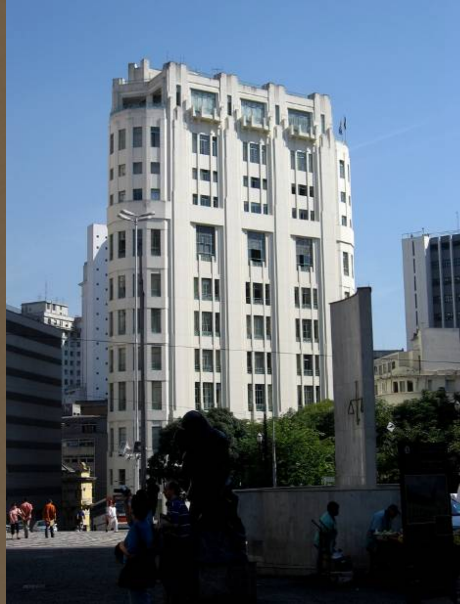
Edifício Saldanha Marinho, 2007. [3, C]
