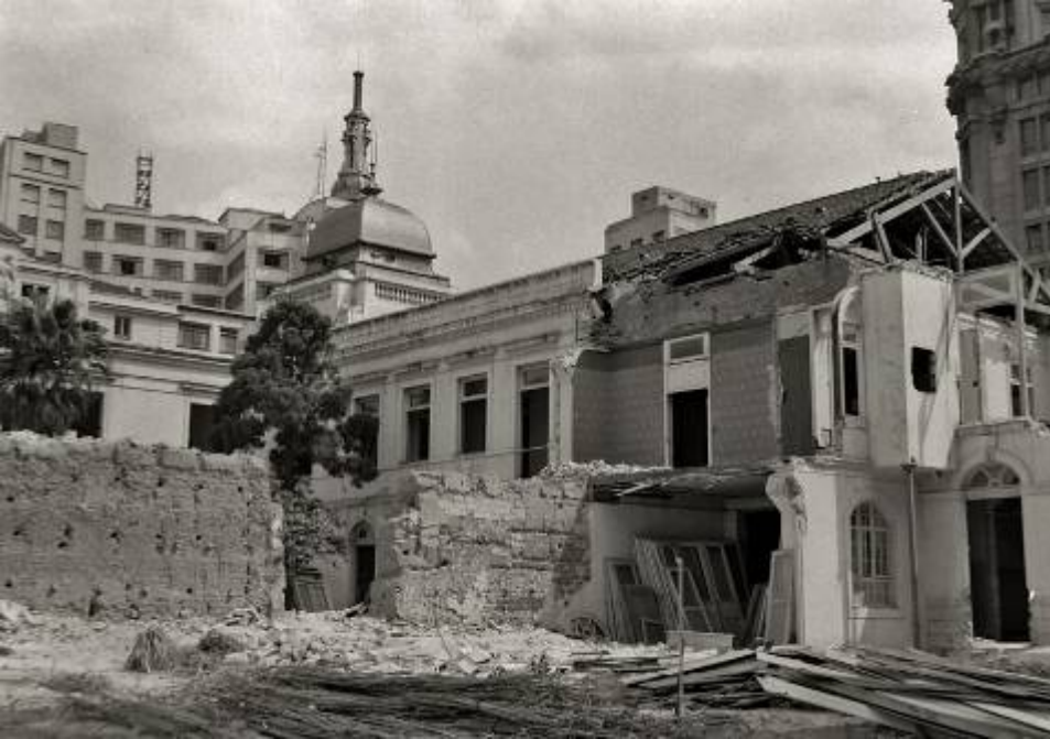
Demolição do Palácio do Governo , no Pátio do Colégio, déc.1950. [5, A]
