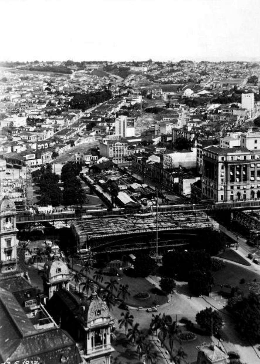
Viaduto do Chá e Edifício Matarazzo, em obras. Ao fundo, o Bexiga, 1935. [6, A]
