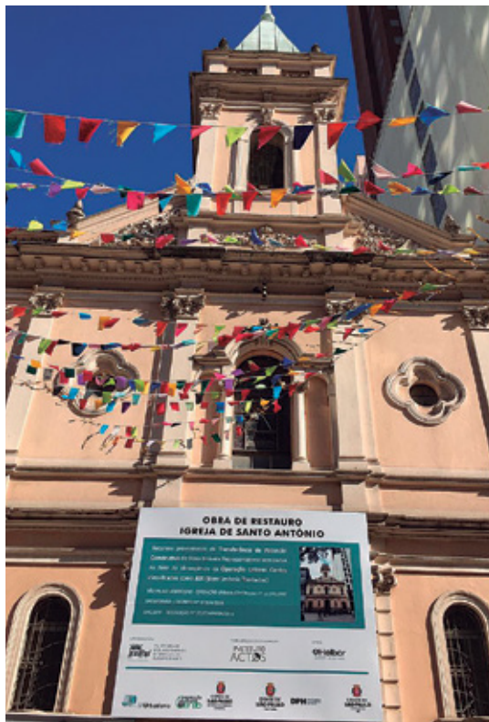
Figura 3 e 4: Obras no interior do Mosteiro de São Bento e obras na Igreja de Santo Antônio, na Praça do Patriarca, viabilizadas pelos recursos adquiridos por meio da transferência de potencial construtivo.
