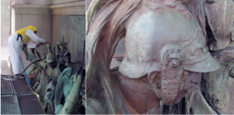
Figura 3: Na imagem à esquerda é apresentada a limpeza geral por projeção de abrasivos vegetais. À direita, detalhe da limpeza: as áreas mais escuras foram as que receberam a higienização. AMARGER, 2016, p. 300
