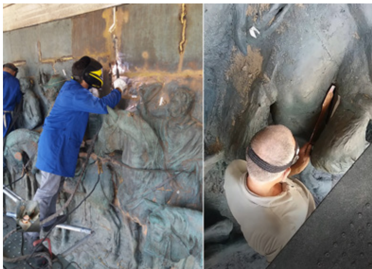
Figura 6: À esquerda, preenchimento de fissuras sendo realizado por meio de solda. Na imagem à direita, a implantação de chapa em bronze modelada manualmente para a implantação nos orifícios maiores. Foto: Alice Américo, 12/10/2016. Acervo DPH/SS/NMOA
