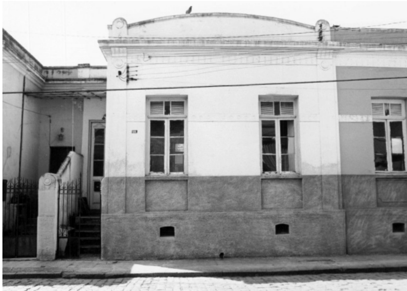
Figura 13 Foto da fachada tipo D , 1979.
