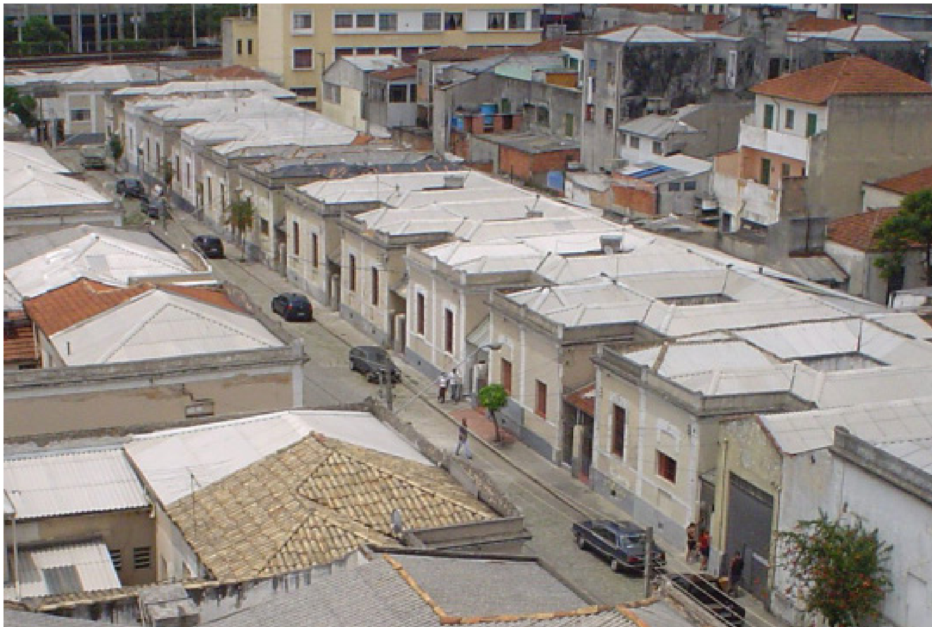
Figura 17 Fachada Rua dos Cantores em 1978.
