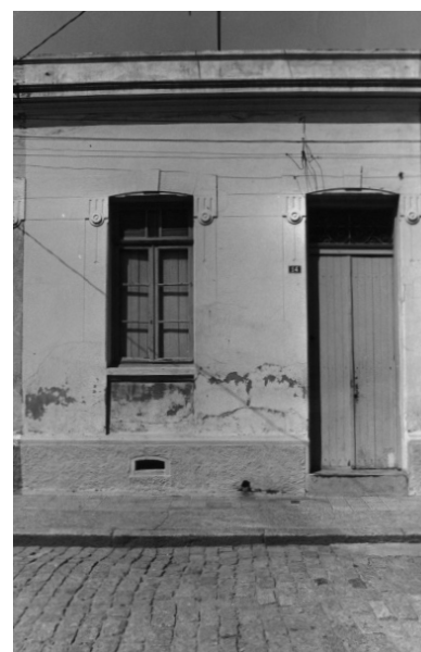
Figura 11 Foto da fachada tipo B , 1979.
