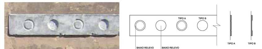
Figuras 33 e 34 Na foto, situação do ornato da fachada em 2009 e, ao lado, elevação e corte da proposta para restauração.
