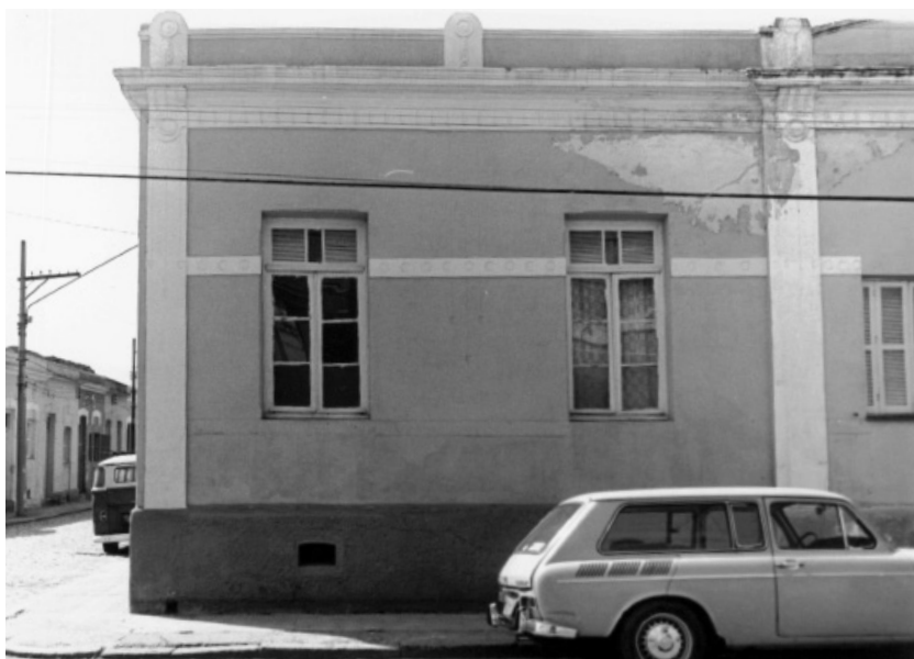
Figura 10 Foto da fachada tipo A , 1979.
