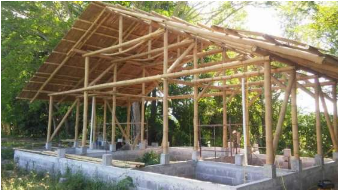
Figura 78. Referencial: Sala Verde (CEU Jardim Campinas), construção com estrutura de bambu.
