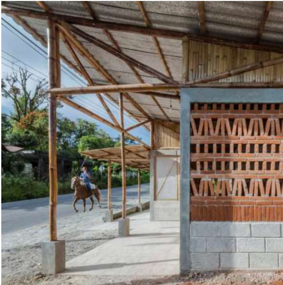
Figura 79. Referencial: Sala Verde (CEU Jardim Campinas), construção com estrutura de bambu.
