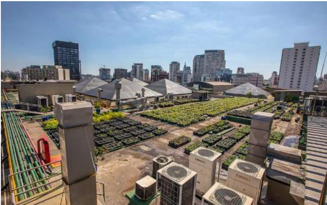
Figura 40. Referencial: Horta e compostagem em laje de cobertura de Shopping Center.
