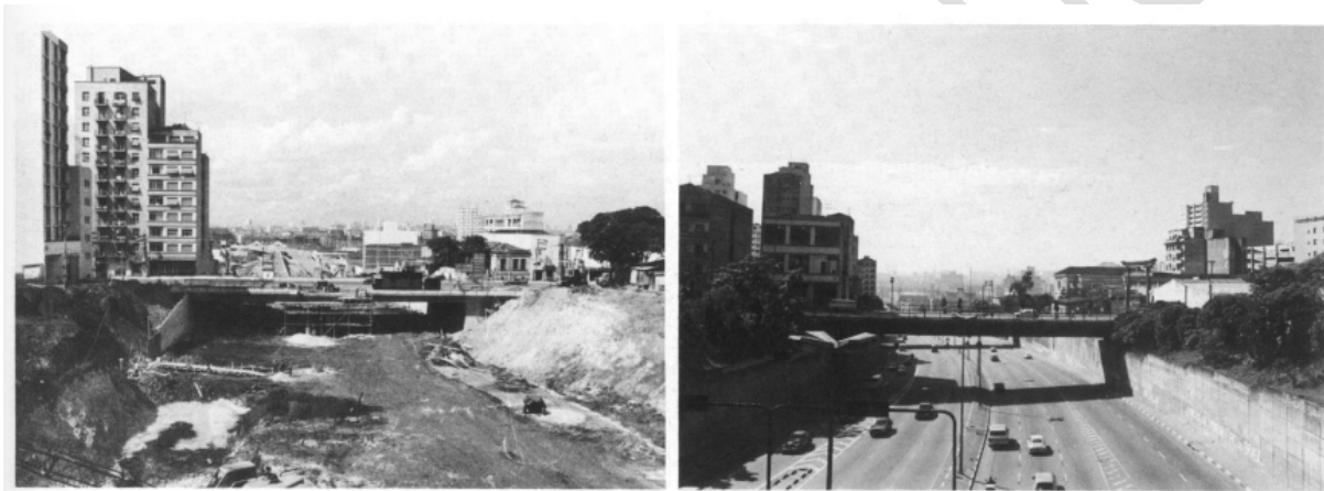
Figura 14 - Demolição para a construção da Avenida Leste-Oeste, 1972 e 1984
