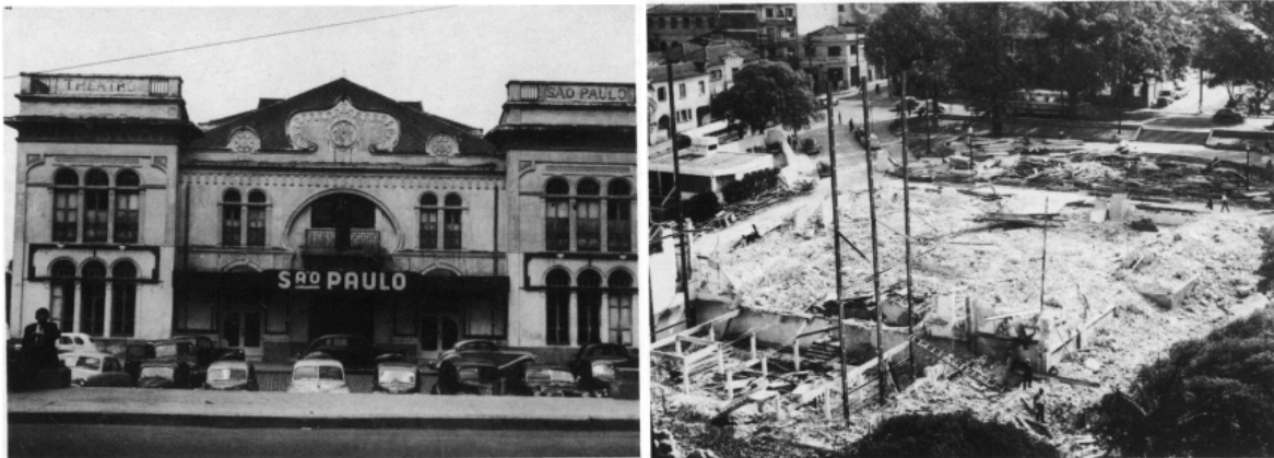
Figura 12 - Teatro São Paulo antes e depois da demolição
