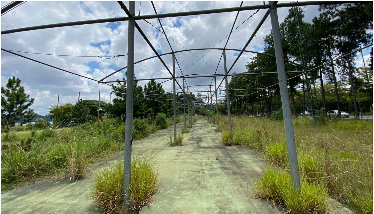
Figura 35 - Foto da estrutura metálica sem uso no terreno do futuro PARQUE PRAIA SÃO PAULO - NÚCLEO ATLÂNTICA
