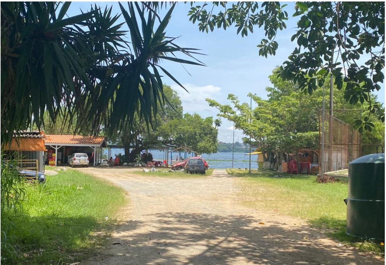
Figura 41 – Construções irregulares do PARQUE PRAIA SÃO PAULO - NÚCLEO PRAIA DO SOL
