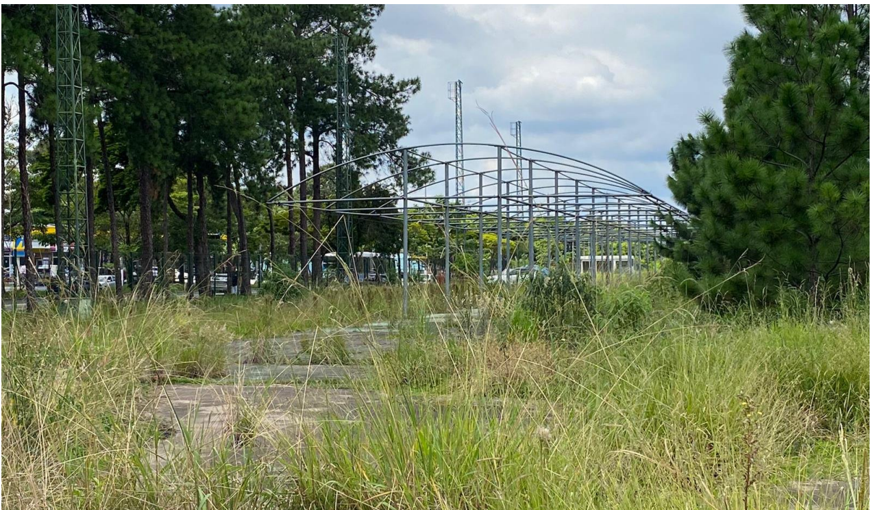
Figura 34 – Foto da estrutura metálica sem uso no terreno do novo PARQUE PRAIA SÃO PAULO - NÚCLEO ATLÂNTICA
