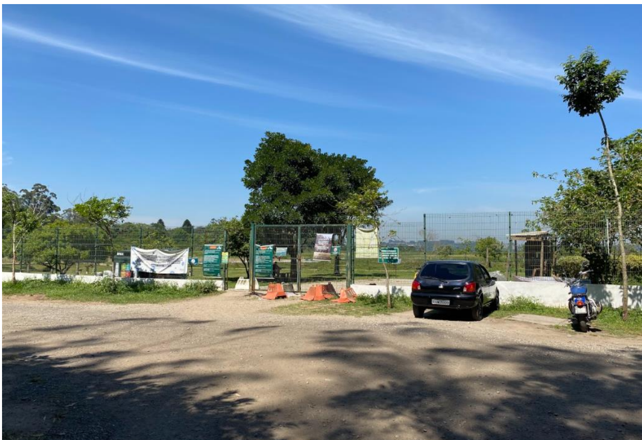
Figura 56 – Vista da entrada principal do parque pela Avenida Ponta do Sol
