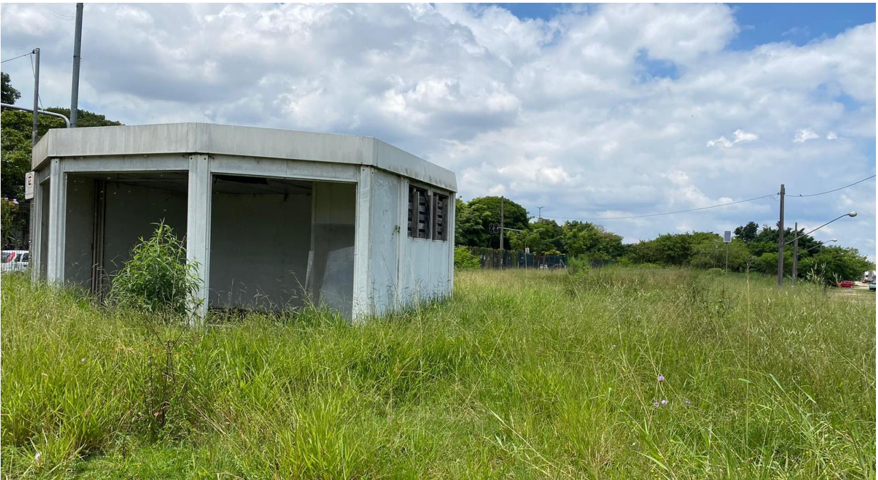
Figura 33 – Foto da edificação sem uso no terreno do novo PARQUE PRAIA SÃO PAULO - NÚCLEO ATLÂNTICA
