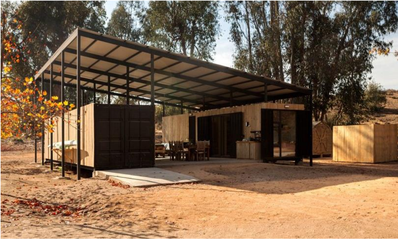
Figuras 53 e 54 – Referências – Administração, infraestrutura de funcionários, WC 1 e Centro de Visitantes em container – no Chile
