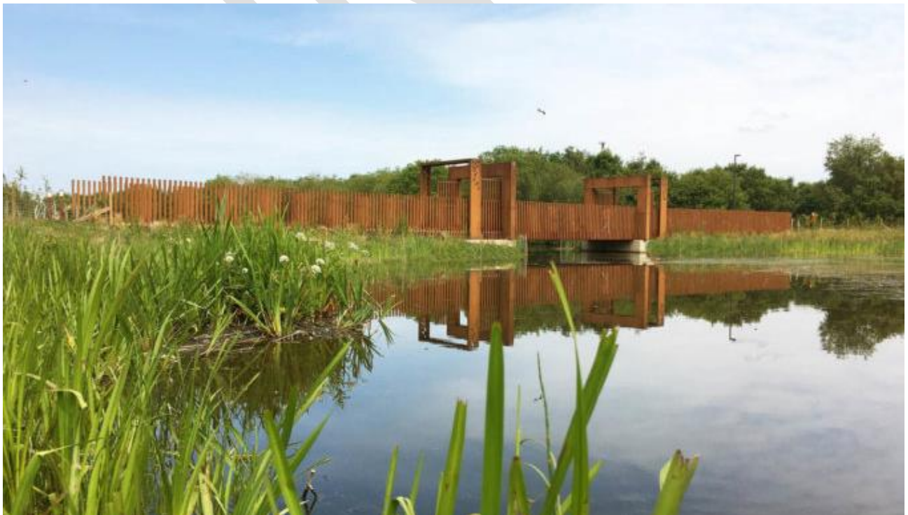
Figura 68 – Referências - Passarela ecoturística do Springfield Dam Park no Reino Unido
