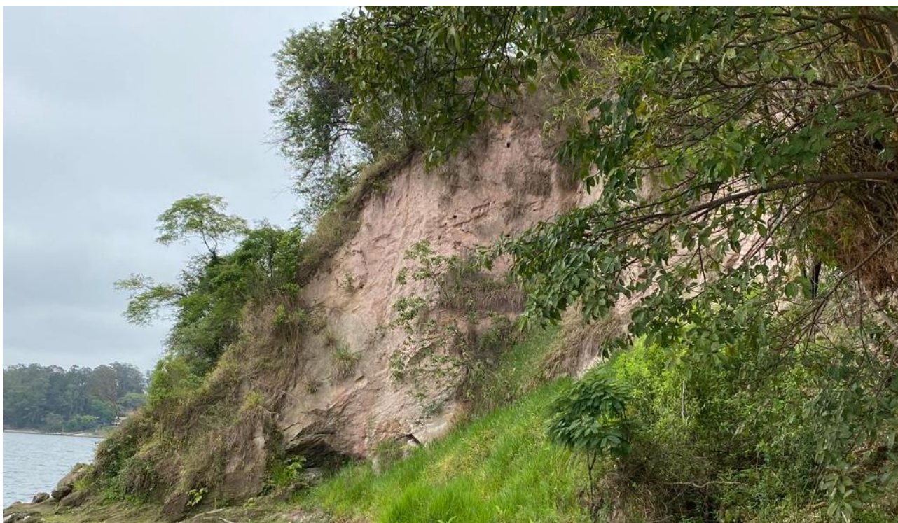
Figuras 88 e 89 – Erosão no talude do PARQUE GUARAPIRANGA e solo exposto dos PARQUE BARRAGEM
