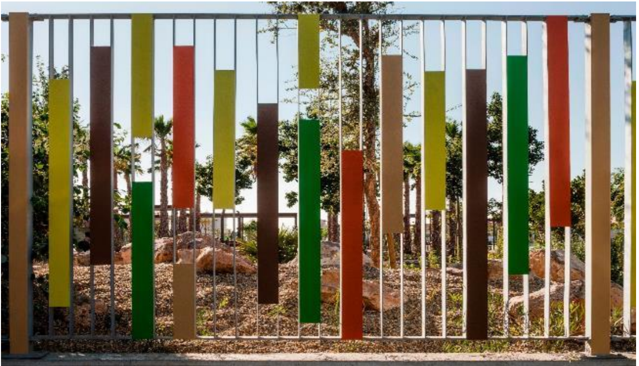
Figura 96 - Imagem de referência - gradil de fechamento
