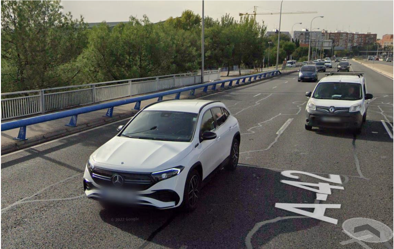
Figura 31 – Imagem de referência - Guard-rail localizado em ambiente urbano (Madrid, Espanha)
