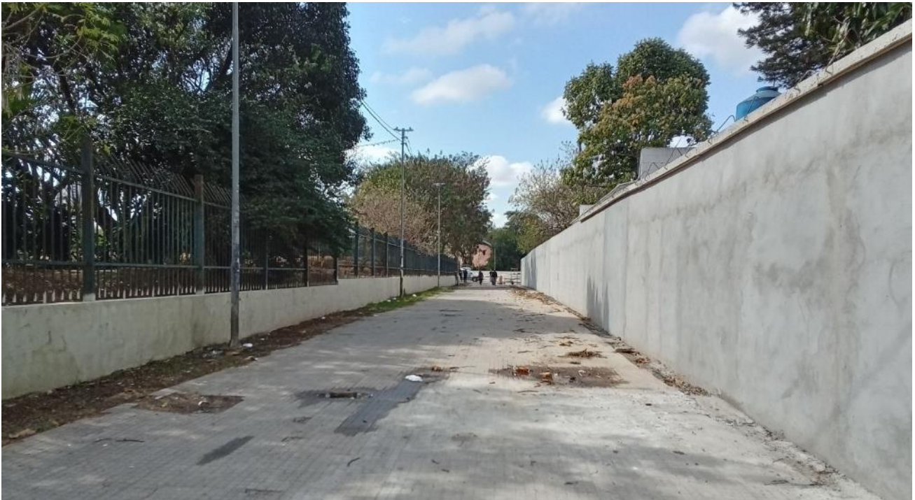
Figura 15 - Vista do caminho de pedestres de conexão ao Gasômetro
