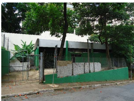
Figura 12- Rua Convenção de Itu x Al. Jaú
