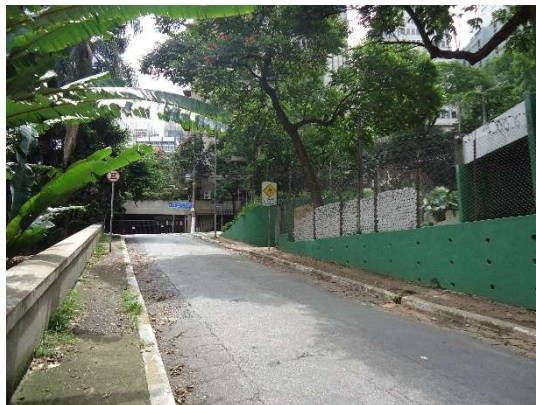
Figura 9 – Rua Convenção de Itu x Al. Jaú
