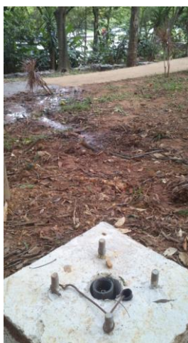
Fig. 1 - Caixa de passagem concretada, ponto de alagamento novo escorrendo sobre a pista de cimento – recebido em janeiro de 2025
