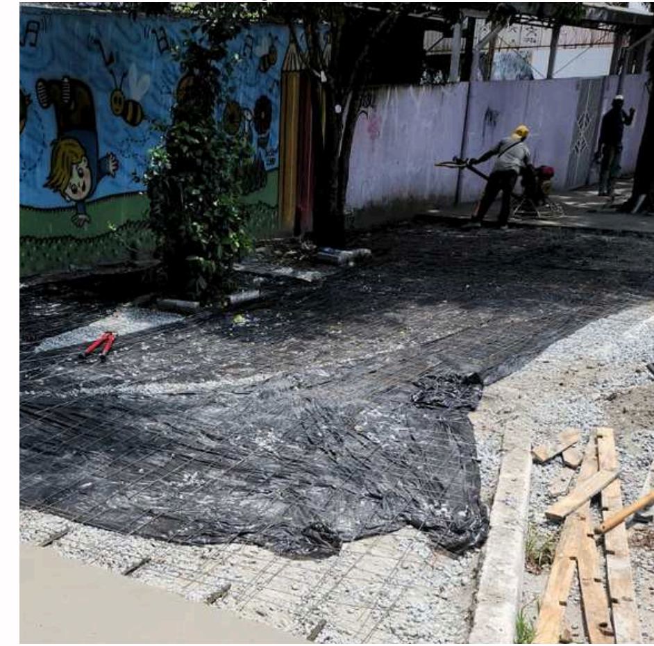
FOTO EM EXECUÇÃO:
