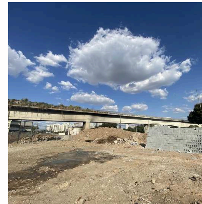
Foto em execução:
