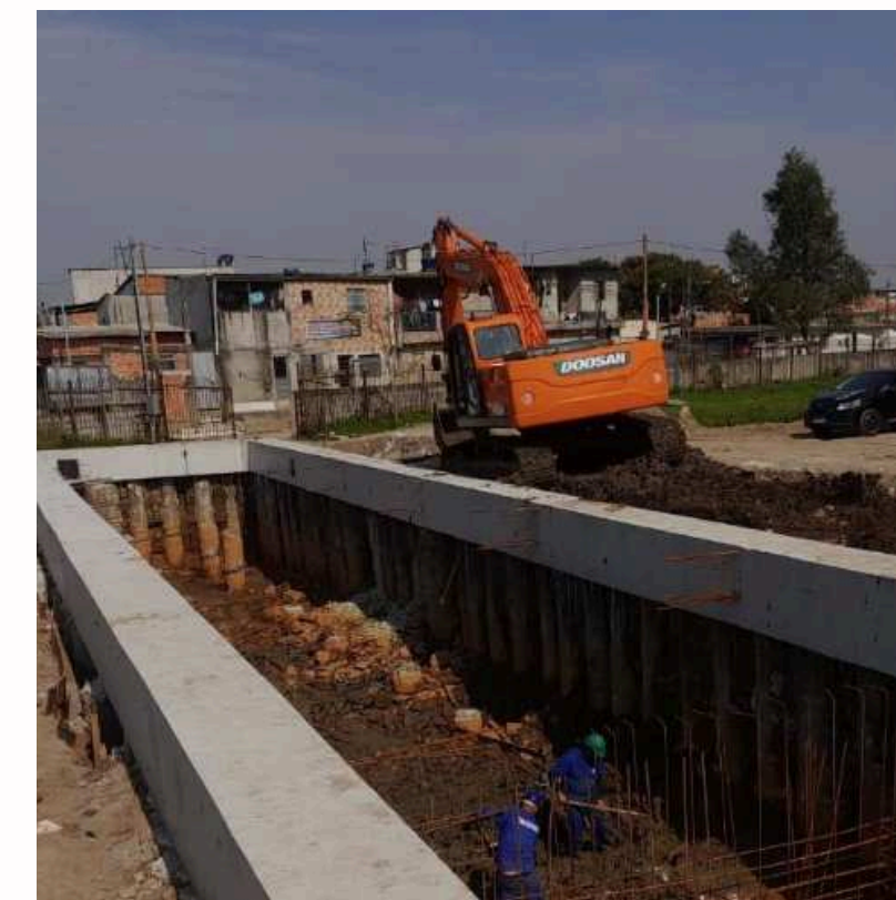
Foto em Execução:
