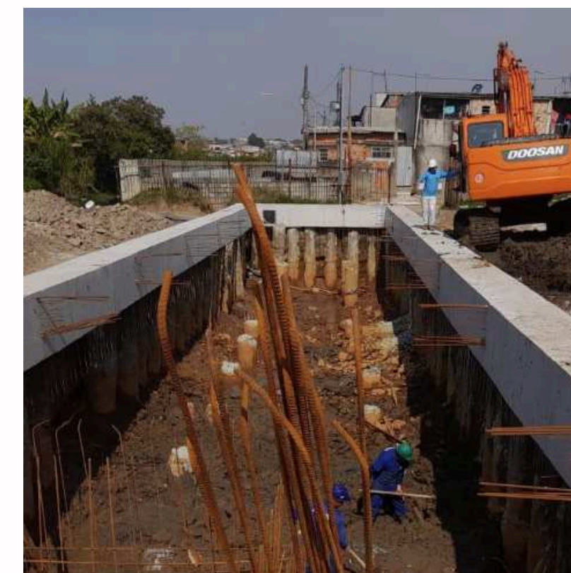
Foto em Execução:
