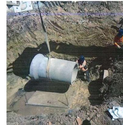
Assentamento do tubo de concreto na rede de drenagem da via - Foto: maio/24
