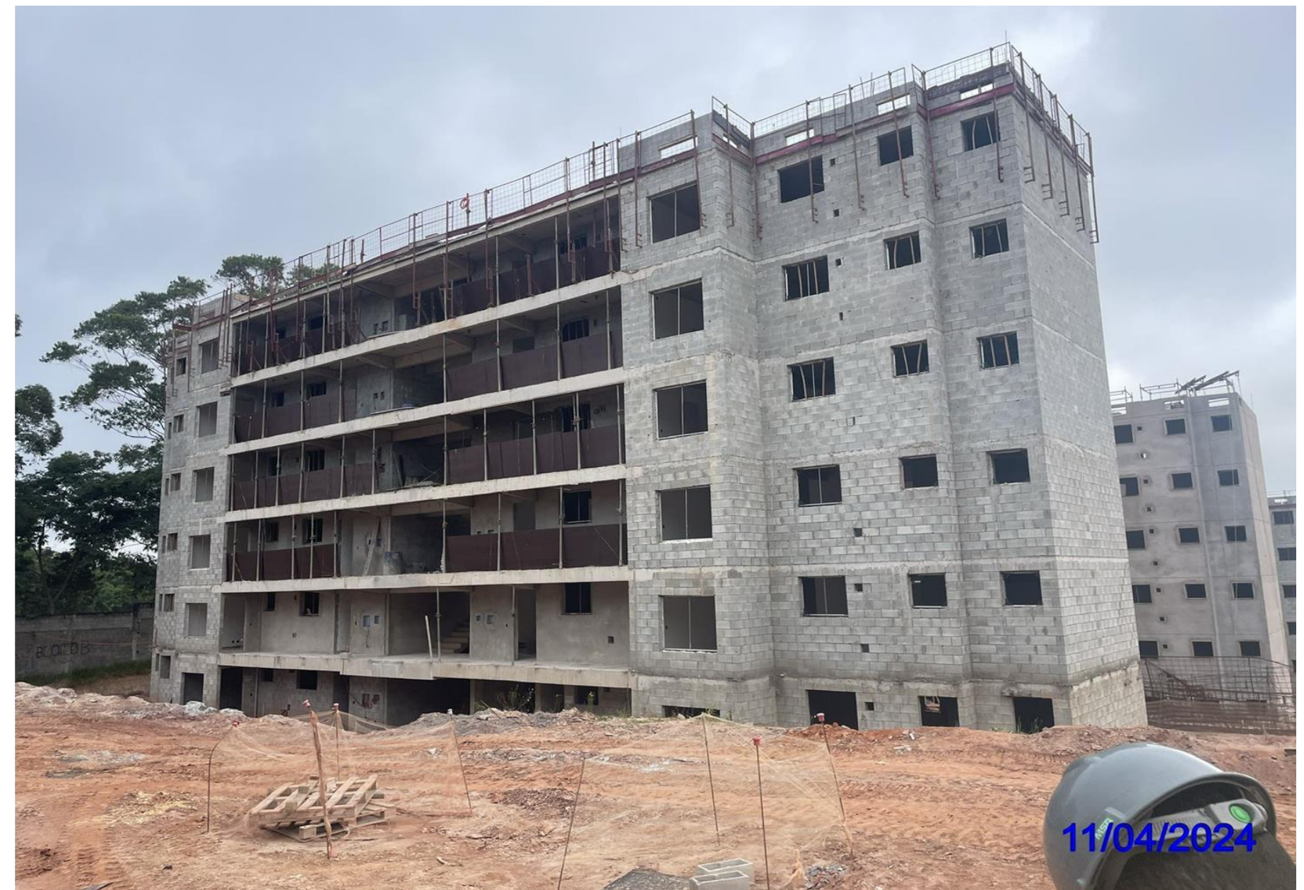
Obra em andamento de provisão habitacional. Vila do Sol. Abril/2024.
