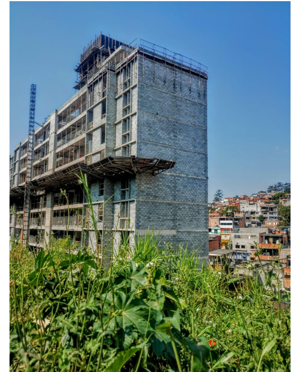
Obra de provisão em andamento. Ago./2024.
