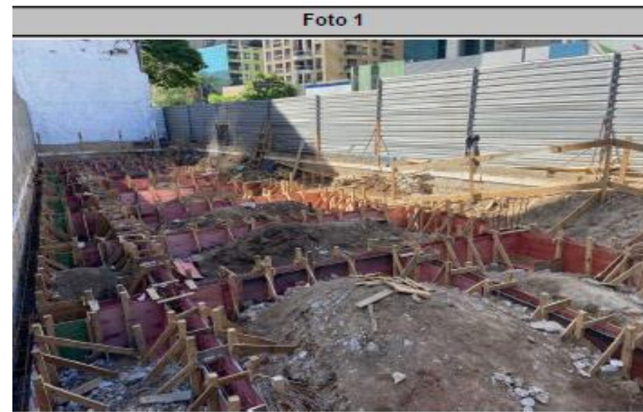
Armação de vigas baldrame, blocos e arranques
