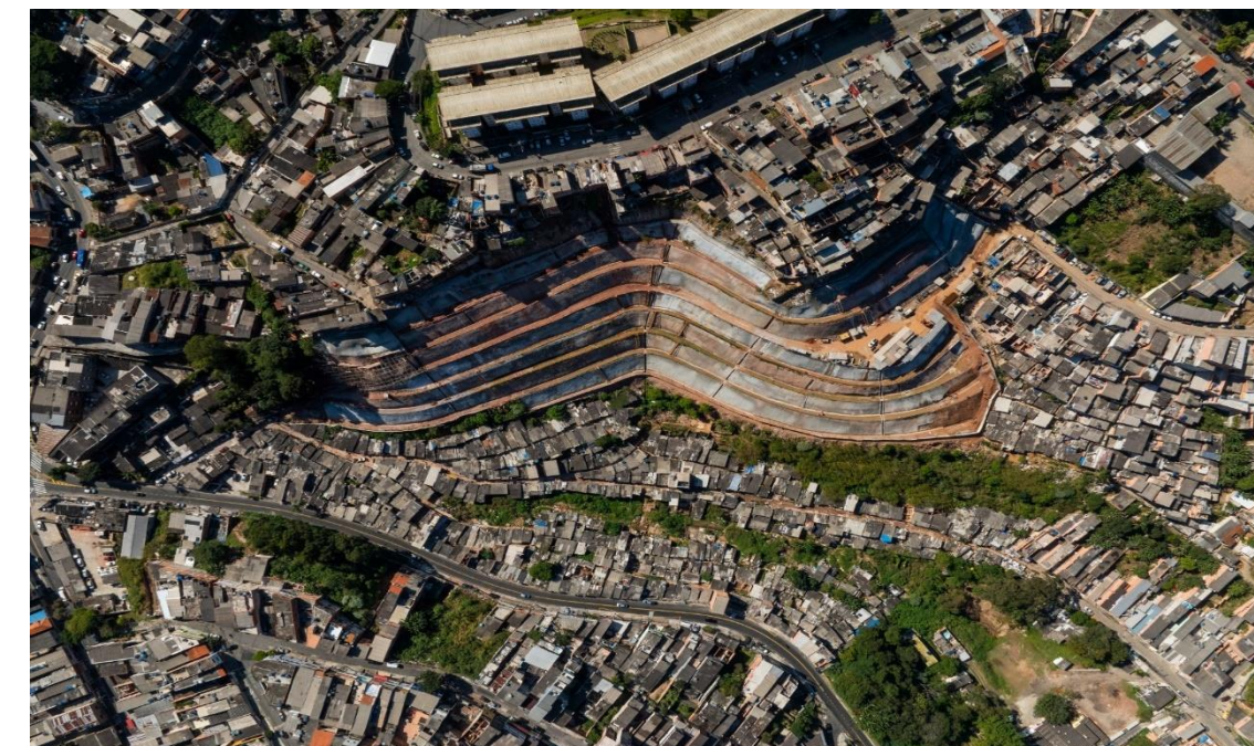
Morro dos Macacos. Contenção em andamento. Jul/24.
