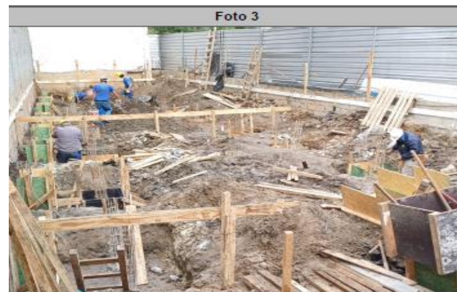
Execução montagem dos Blocos de Fundação
