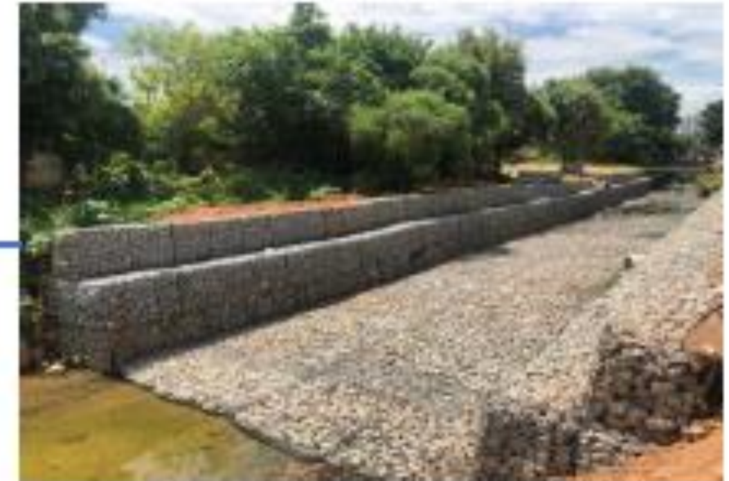
Canalização do córrego – Abril /2024
