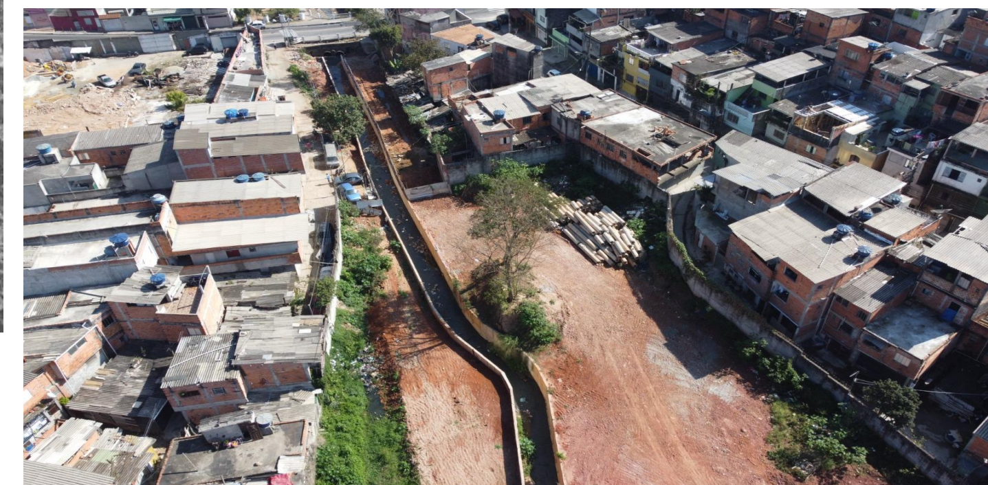
Jd. Primavera. Canalização de córrego. Jul/24.
