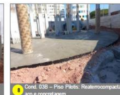
7 Cond. 03B – Estrutura pilares Pilotis: Desforma
