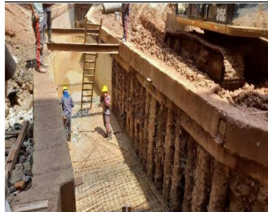
Foto da canalização do córrego Antonico - julho/2024
