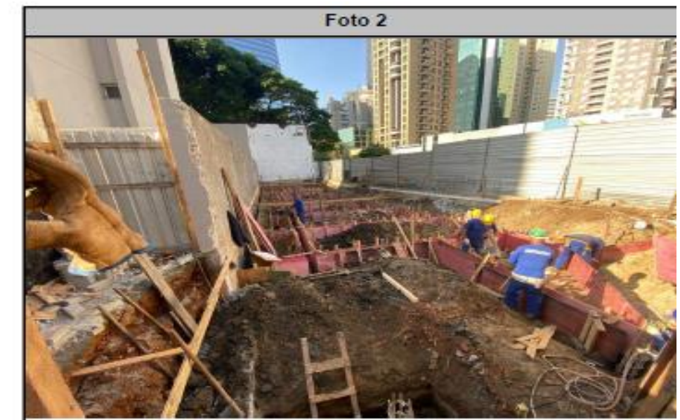
Arrasamento de estacas e montagem das formas das vigas
