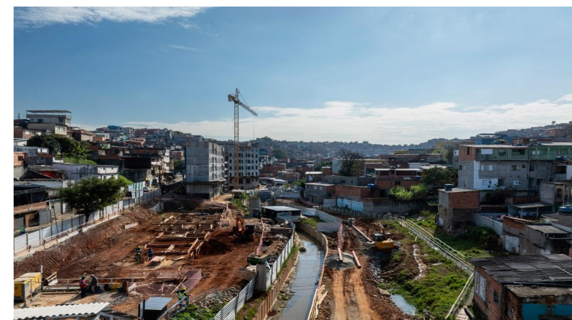
Guaicuri. Canalização de córrego e provisão habitacional. Jul/24.
