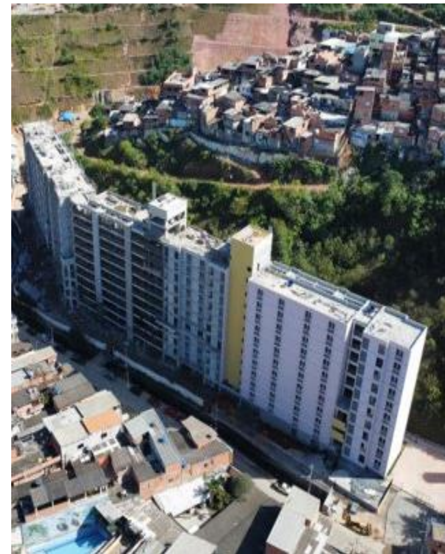
Execução de fachada da provisão. Junho/2024.
