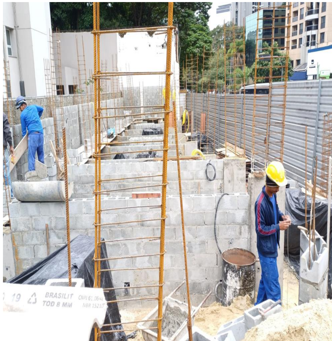
Execução de alvenaria dos Box ao lado dos prédios – Julho /2024
