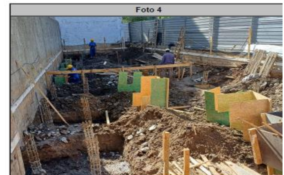
Execução das formas da fundação dos boxes
