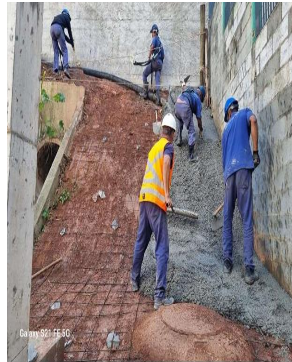
Execução da concretagem do Talude
