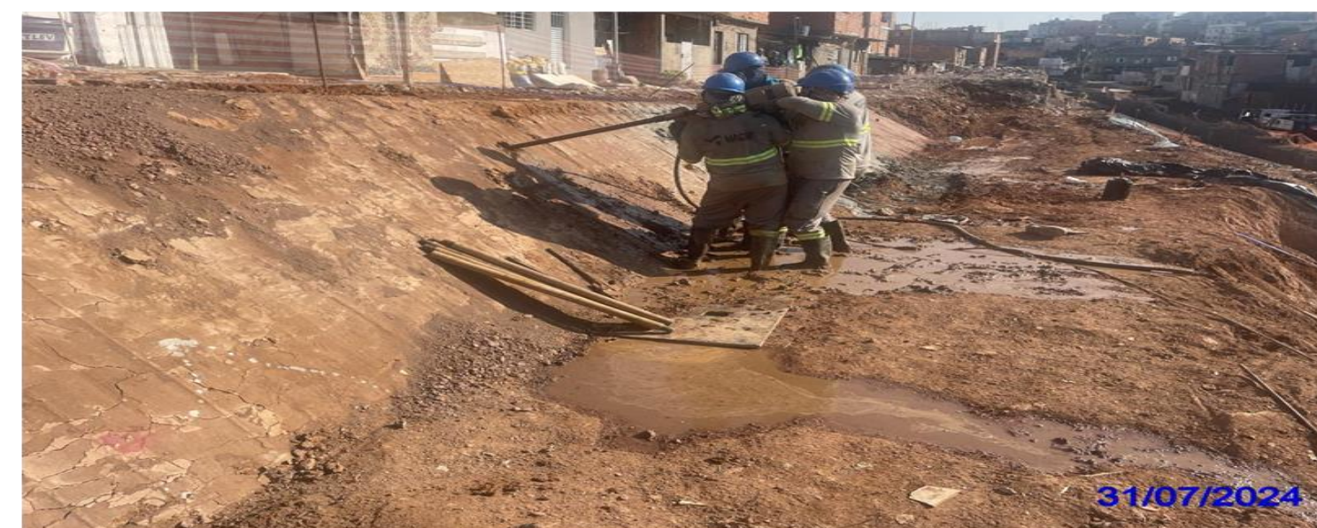
Jardim Ângela. Obra em execução. Jul/2024
