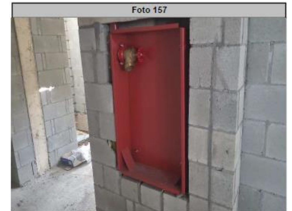
Torre 3 - 14º Pavimento - Montagem das caixas dos hidrantes
