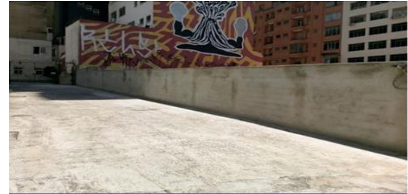
Serviços de reparo do muro de divisa em alvenaria, muro de divisa em placas, poços de visita e calçada. Limpeza final da obra.
