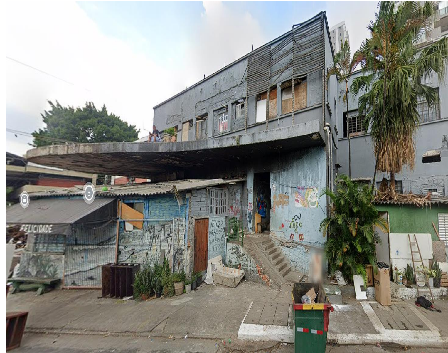
prédio será demolido para construção de unidades habitacionais
