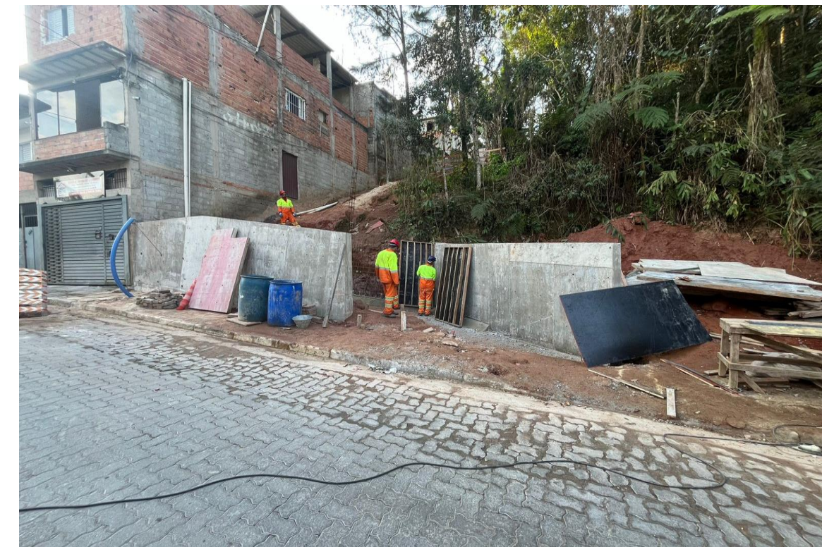
Centro de Parelheiros. Contenção. Ago./2024.
