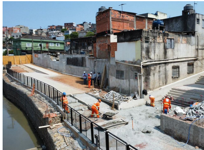
Córrego e calçada. Jardim Ângela. Out./2024.
