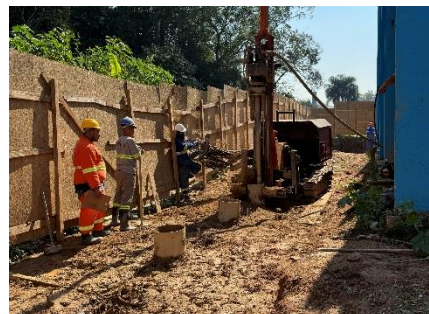
Redes de saneamento básico. Jararaú II. Ago./2024.
