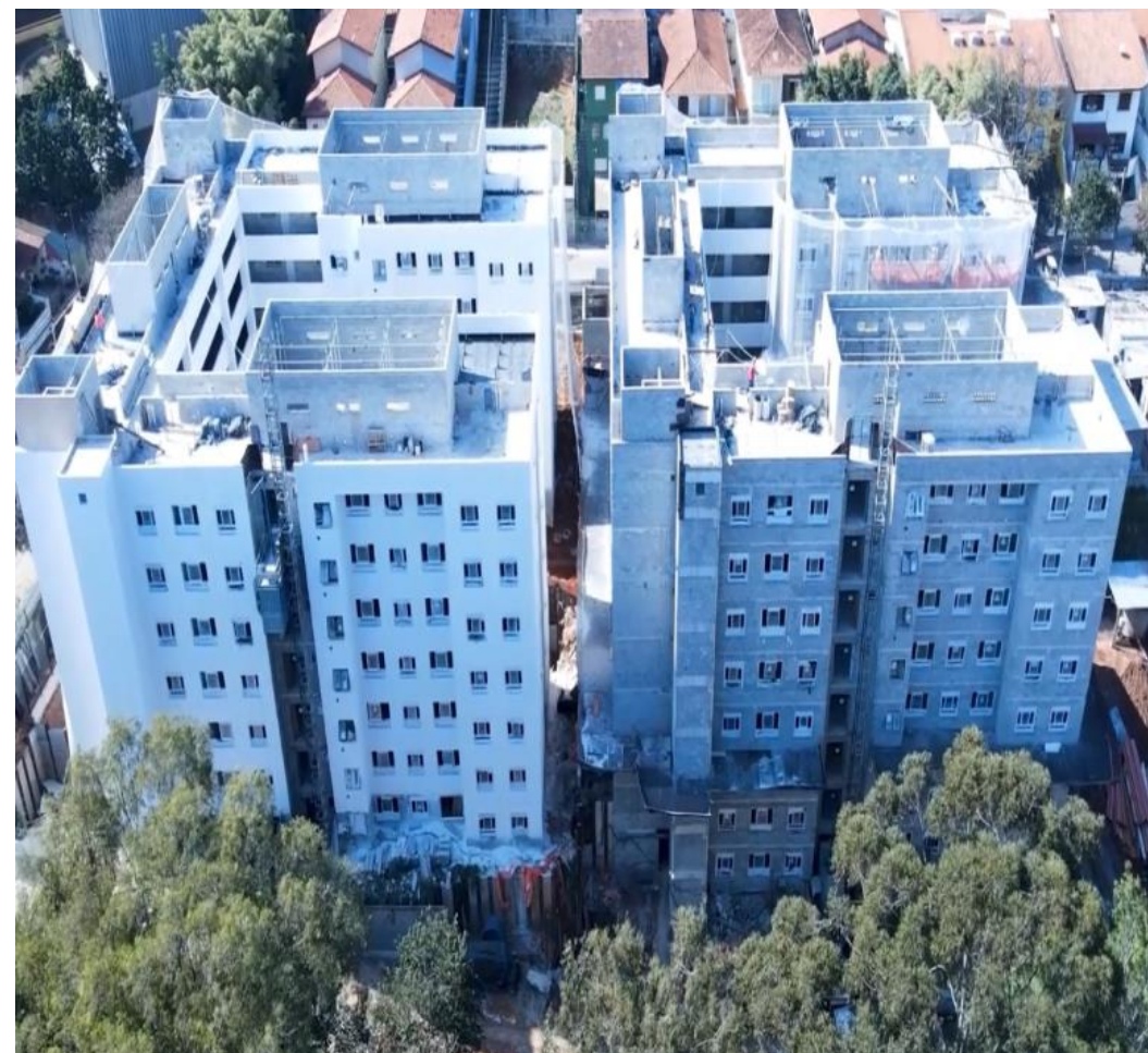
Vista do Condomínio 1 e 2 – Domênico Martinelli. Fotos: setembro/24
