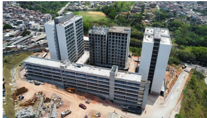
Execução da provisão – Vila Nordestina. Out./2024
