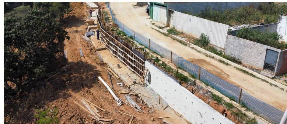
Jardim Gaivotas I. Contenção. Set./24.
