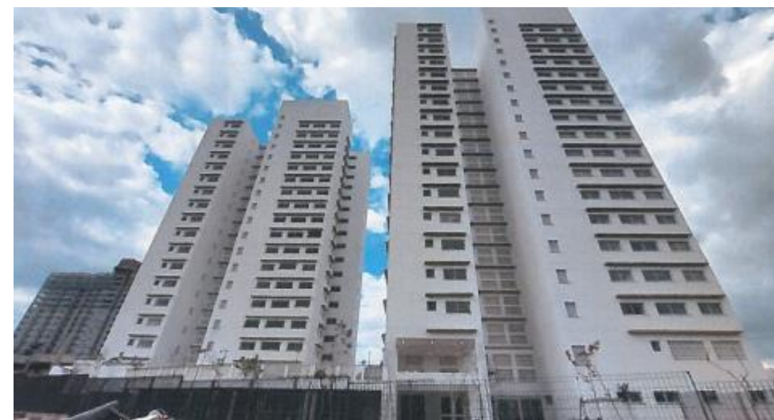
Fachadas Torres A e B – Foto: maio/24
