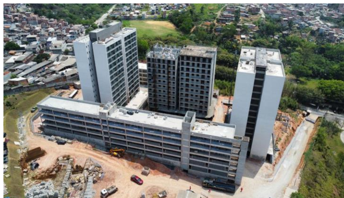
Execução da provisão – Vila Nordestina. Out./2024
