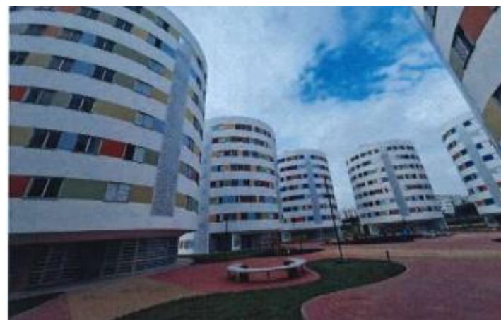
Condomínio 5 - Instalação dos Brises- Foto: maio/24
