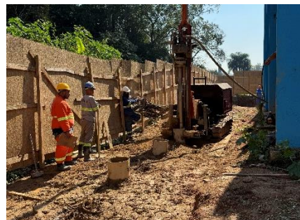
Redes de saneamento básico. Jararaú II. Ago./2024.
