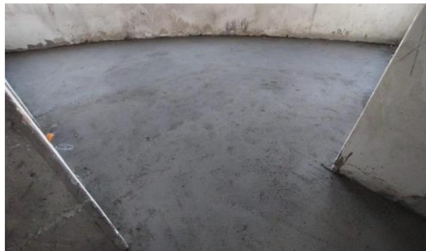
Execução de contrapiso apartamentos - Foto: agosto/24
