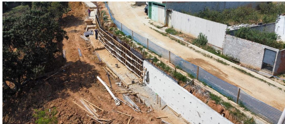
Jardim Gaivotas I. Contenção. Set./24.
