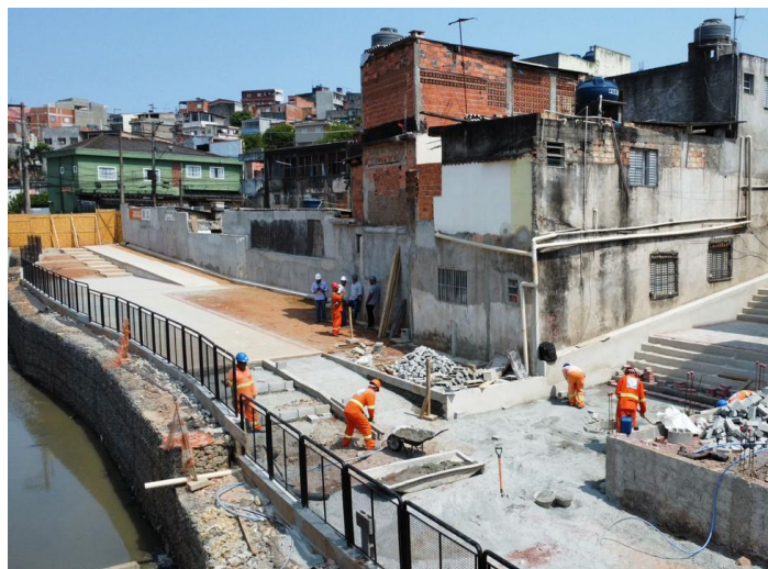
Córrego e calçada. Jardim Ângela. Out./2024.
