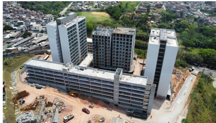
Execução da provisão – Vila Nordestina. Out./2024
