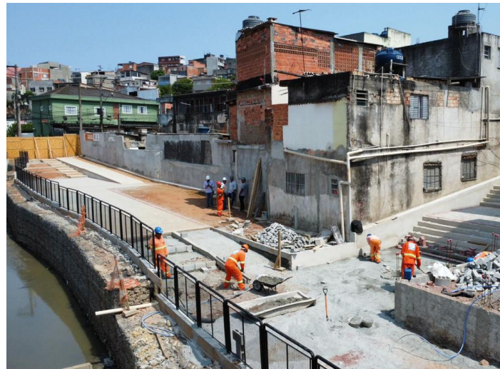
Córrego e calçada. Jardim Ângela. Out./2024.
