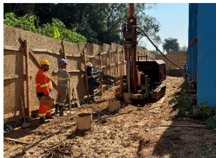
Redes de saneamento básico. Jararaú II. Ago./2024.
