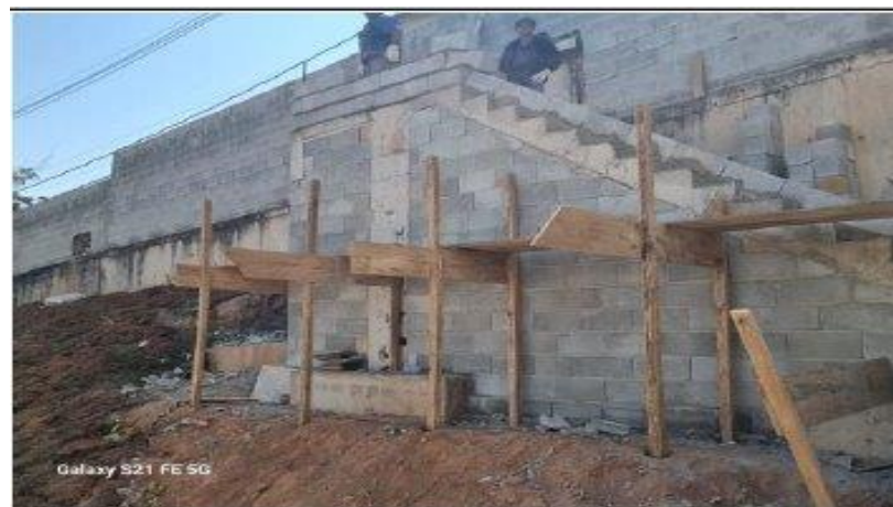
Execução da Escadaria – Guarda Corpos - Foto: agosto/24
