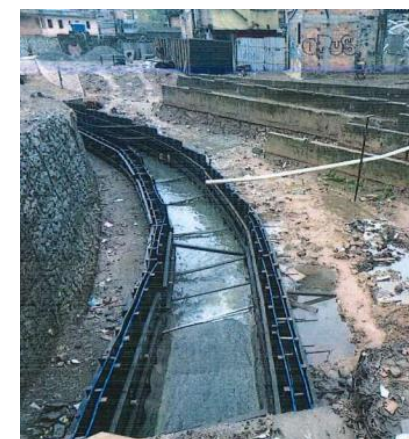
Vista das paredes da mureta após montagem das formas – Foto: maio/2024
