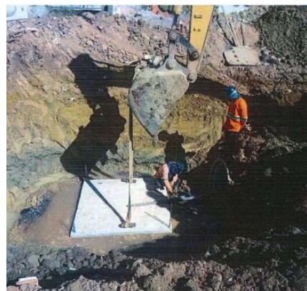
Assentamento do piso laje do poço de visita nº28 - Foto: maio/24
