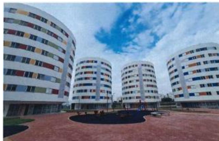
Condomínio 5 - Instalação dos Brises- Foto: maio/24
