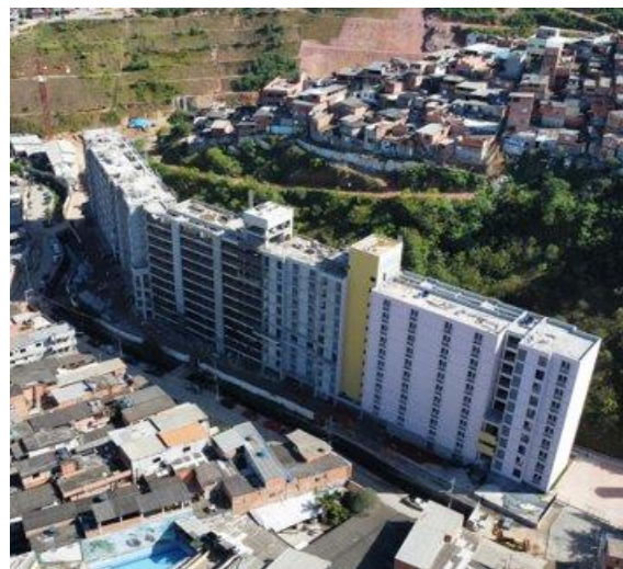
Execução de fachada da provisão. Junho/2024.
