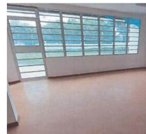
Piso vinílico Creche – Foto: maio/24
