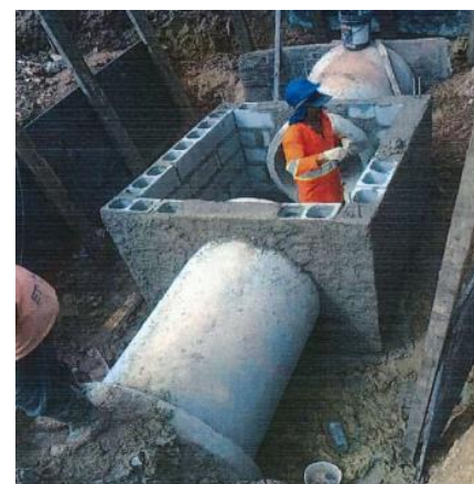
Alvenaria e concretagem do PV 28 - Foto: maio/24
