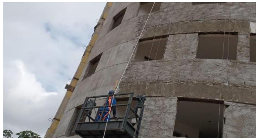
Recuperação fachada- Foto: agosto/24
