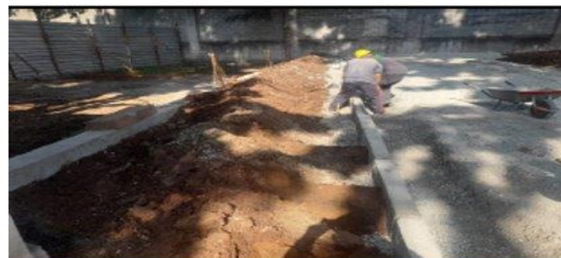
Execução de guias – Trecho do muro do Carrefour
