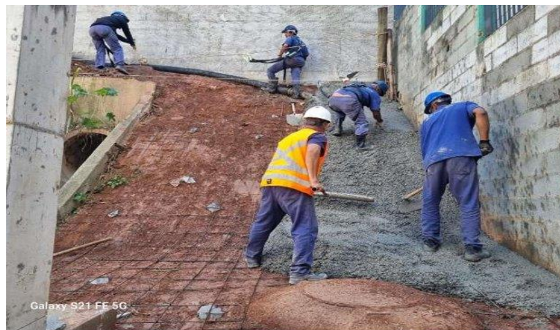
Preparação do Talude e execução da concretagem - Foto: agosto/24
