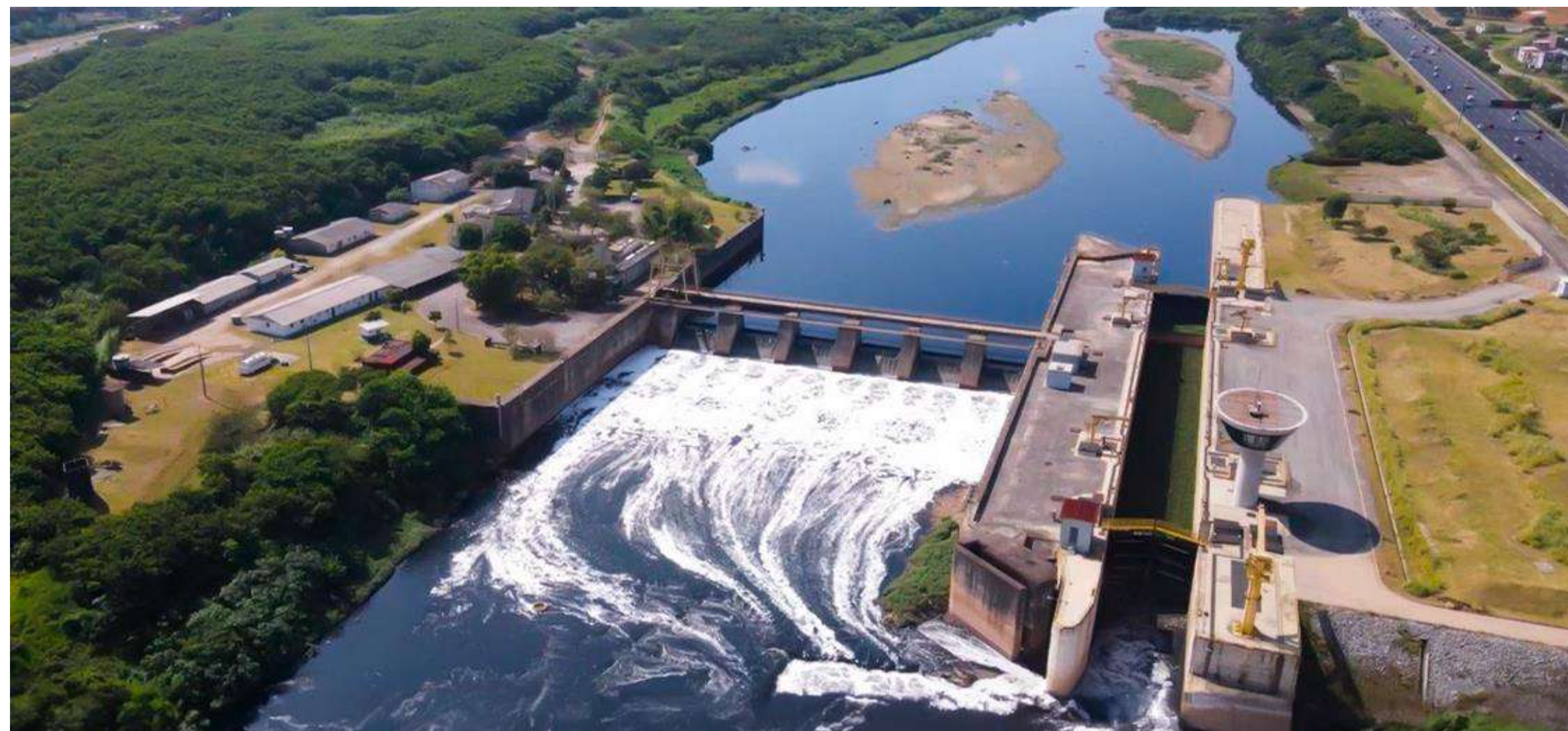
Barragem e Eclusa da Penha, entre os canais do rio Tietê, Central e Leste. Divulgação DAEE
