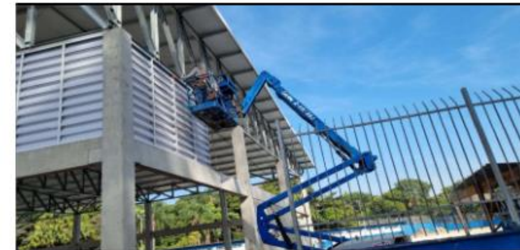
INSTALAÇÃO DAS VENEZIANAS DO GINÁSIO AQUÁTICO
