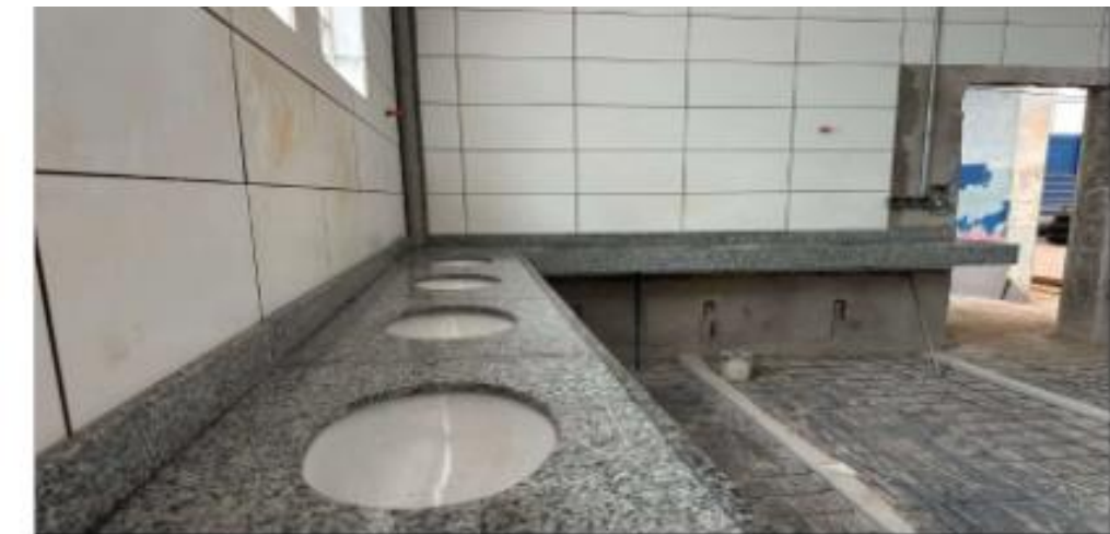
INSTALAÇÃO DAS BANCADAS DE GRANITO - GINÁSIO POLIESPORTIVO - REFORMA
