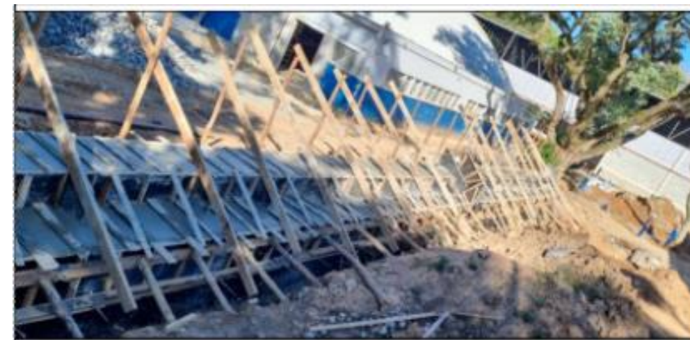
CONCRETAGEM ARQUIBANCADA DE TENIS
