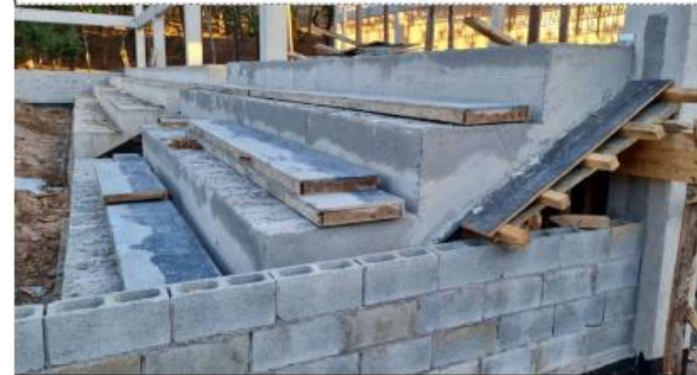
CONCRETAGEM DAS ARQUIBANCADAS DO GINÁSIO DE LUTAS
