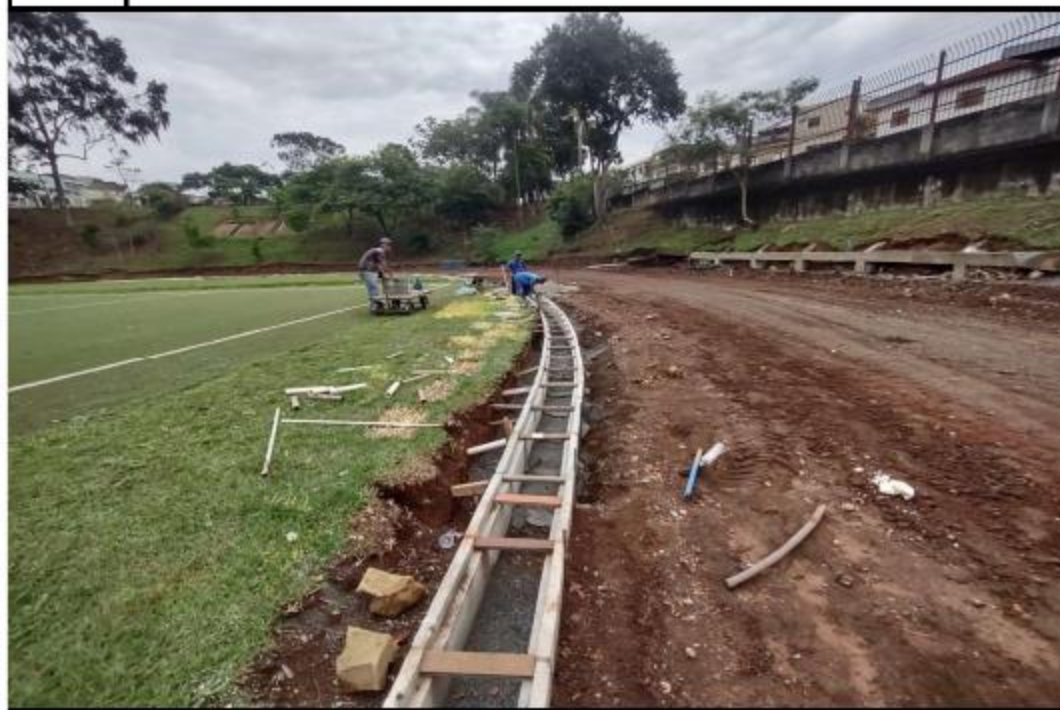
EXECUÇÃO DAS CANALETAS DE DRENAGEM DA PISTA DE ATLETISMO
