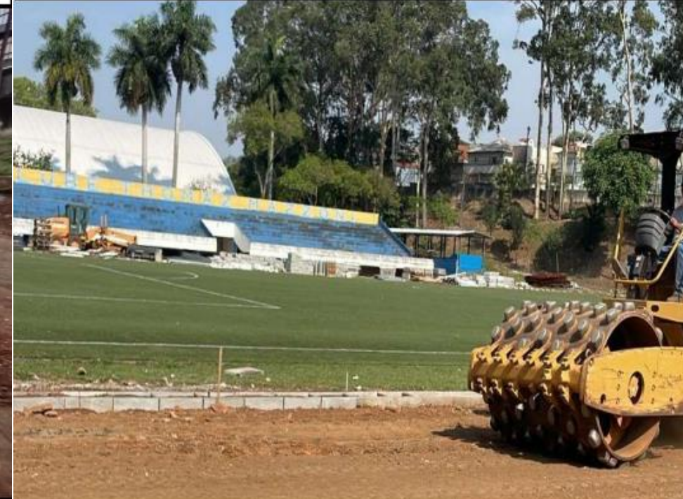
COMPACTAÇÃO DA SUBBASE DA PISTA DE ATLETISMO
