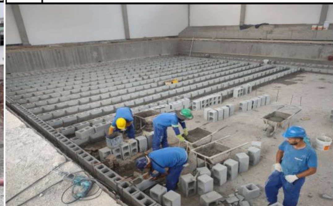
EXECUÇÃO DE LAJE DE FUNDO DA PISCINA DO GINÁSIO AQUÁTICO
