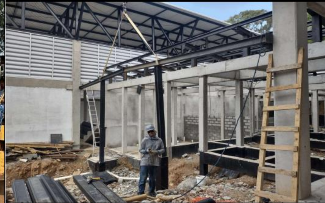
EXECUÇÃO DA ESTRUTURA METÁLICA (E PINTURA) DOS VESTIÁRIOS DOS GINÁSIOS DE HANDBALL E LUTAS
