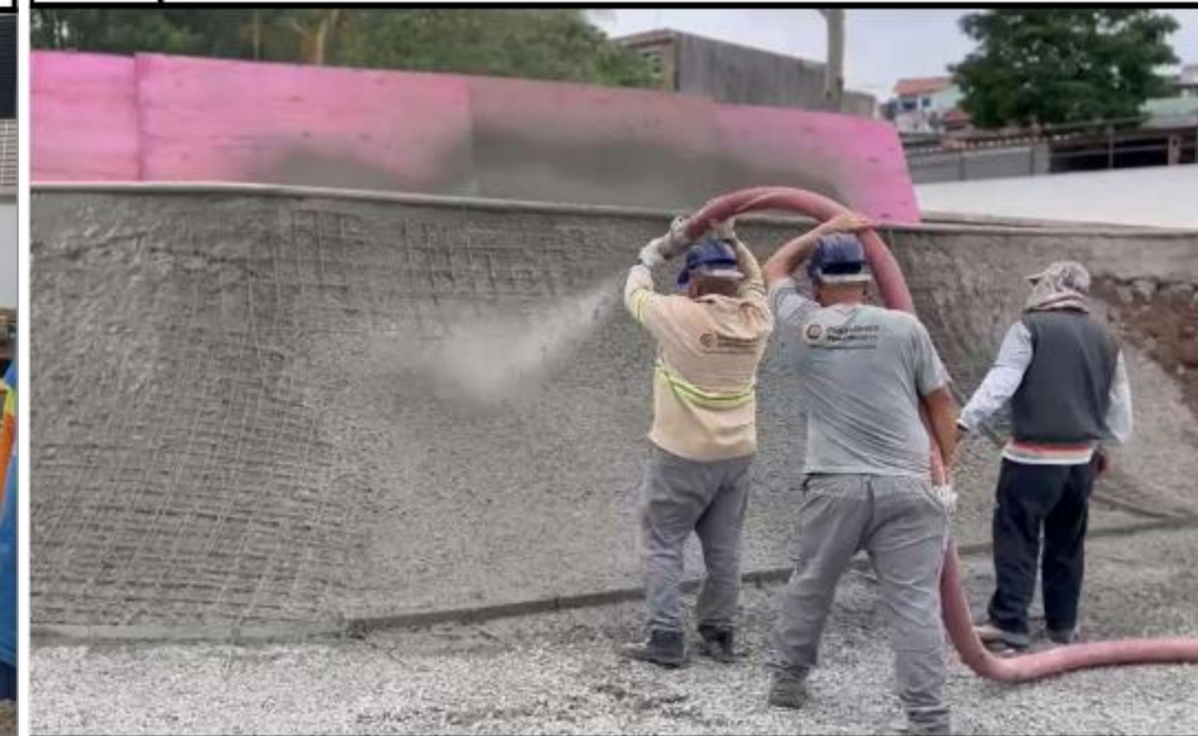
CONCRETAGEM DAS PAREDES DO BOWL - SKATEPARK
