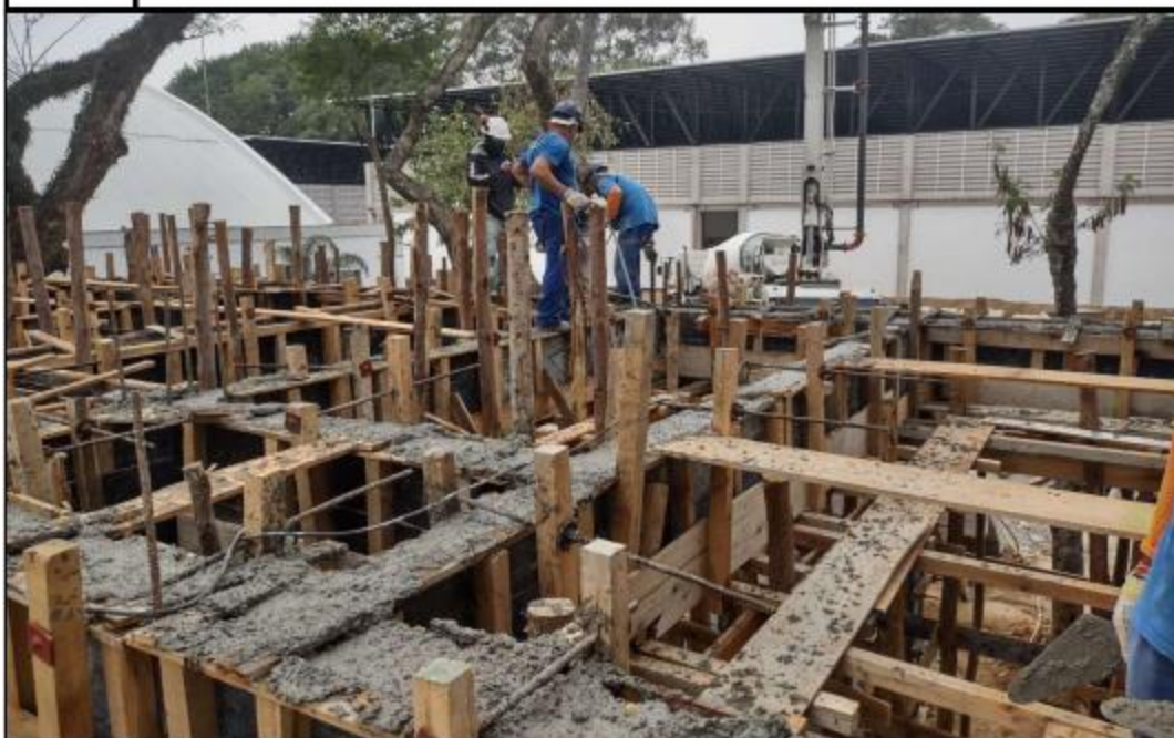
CONCRETAGEM DA ESTRUTURA DE CONCRETO ARMADO - VESTIÁRIO DAS QUADRAS EXTERNAS
