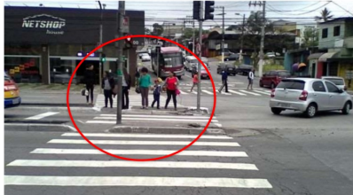
Foto 6- Local com canteiro estreito, conversão à esquerda e travessia em 2 estúdios
