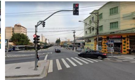
Construção de refúgios e implantação de faixa de pedestres e estágio semafórico específico para pedestres
