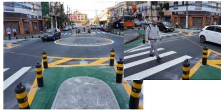
Implantada minirrotatória para redução da velocidade e ordenamento veicular, melhorando a segurança dos pedestres nas travessias e diminuindo a sua exposição ao risco
