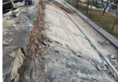
REMOÇÃO DE MANTA E REGULARIZAÇÃO DE BASE
