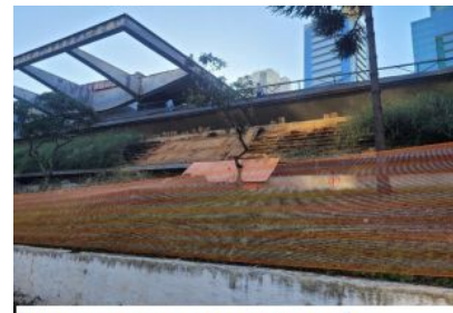
TRATAMENTO DE JUNTA DE DILATAÇÃO
