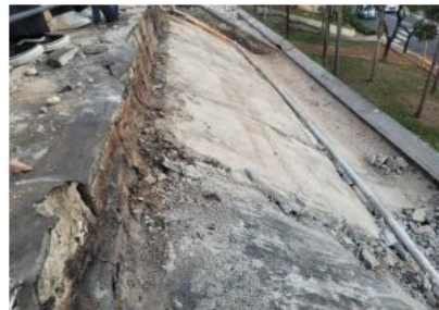
REMOÇÃO DE MANTA E REGULARIZAÇÃO DE BASE
