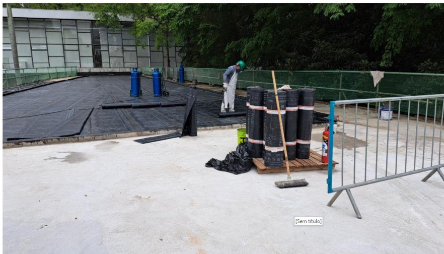
Aplicação de manta asfáltica (impermeabilização) – outubro/2024
