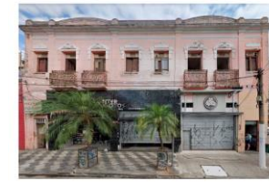
SITUAÇÃO ATUAL (MARÇO DE 2021) DA FACHADA DA CONSTRUÇÃO
