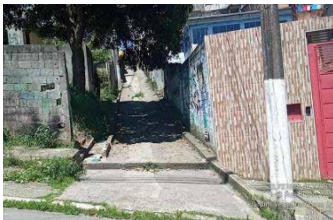
Revitalização de escadão na Rua Bruno Valter, 117 (antes)
