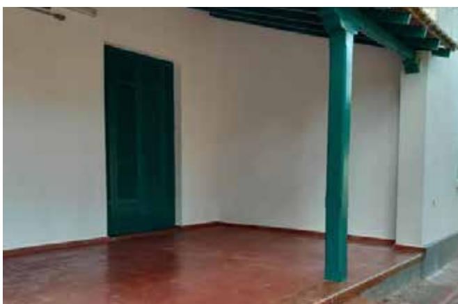
Casa de Cultura Itaquera - Raul Seixas. Restauro e requalificação predial
