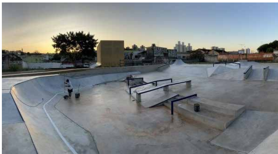
Melhoria de Bairro. Execução de pista de skate, Rua Antônio Carlos de Oliveira Cesar - Itaquera.
