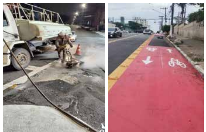
Construção de Ciclovia. Rua Nossa Senhora da Saúde (antes e depois)
