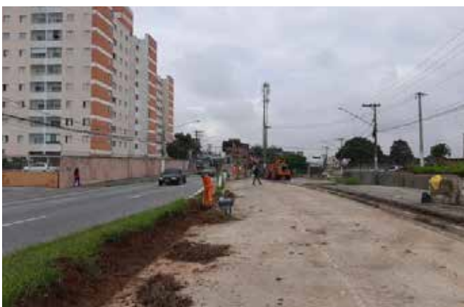
Implantação de corredores de ônibus. Corredor Av. Itaquera-Líder
