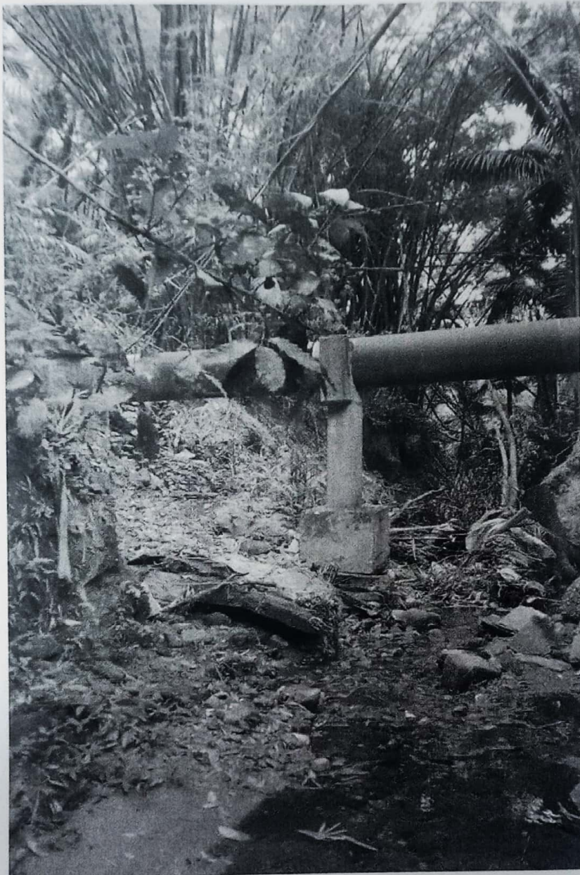
Foto 5: Após quebra do muro
