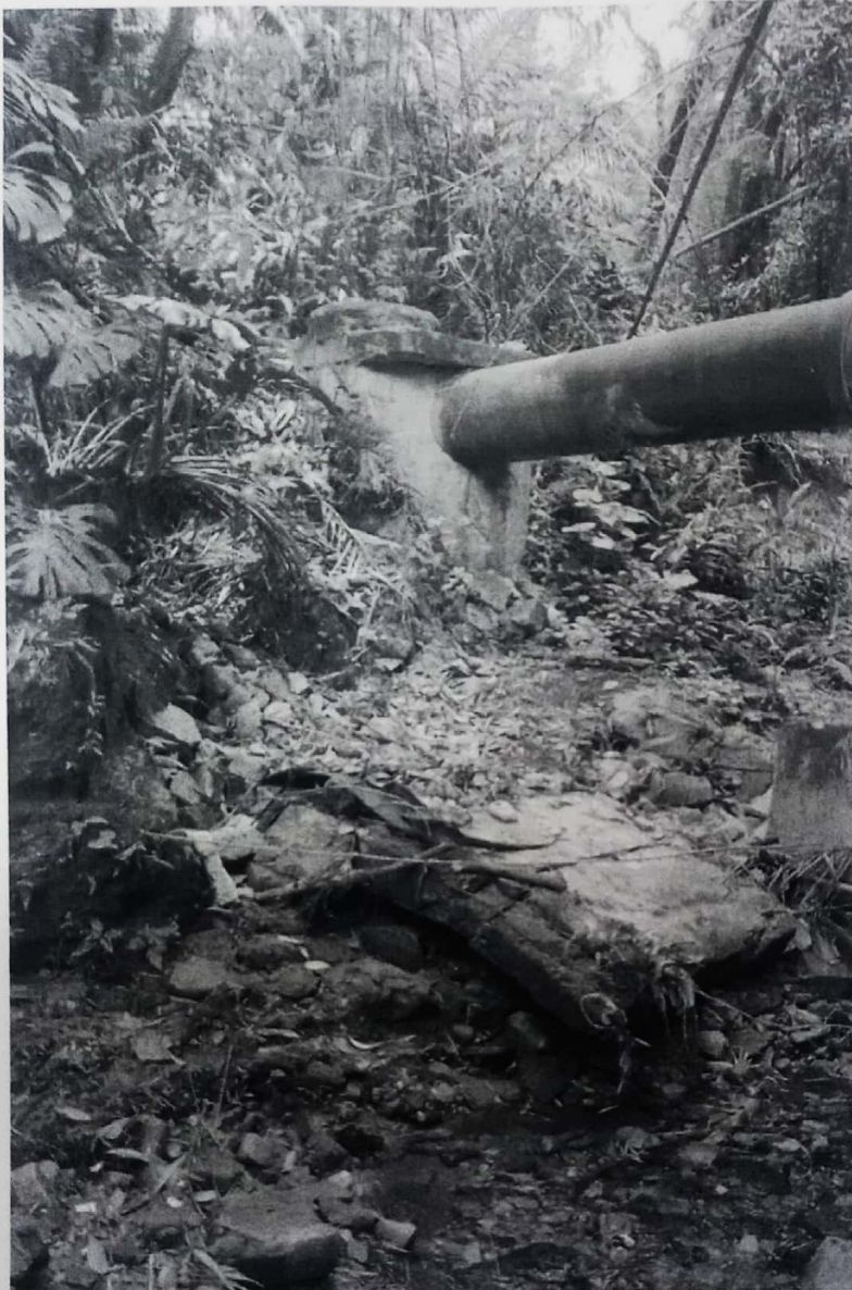
Foto 4: Após quebra do muro
