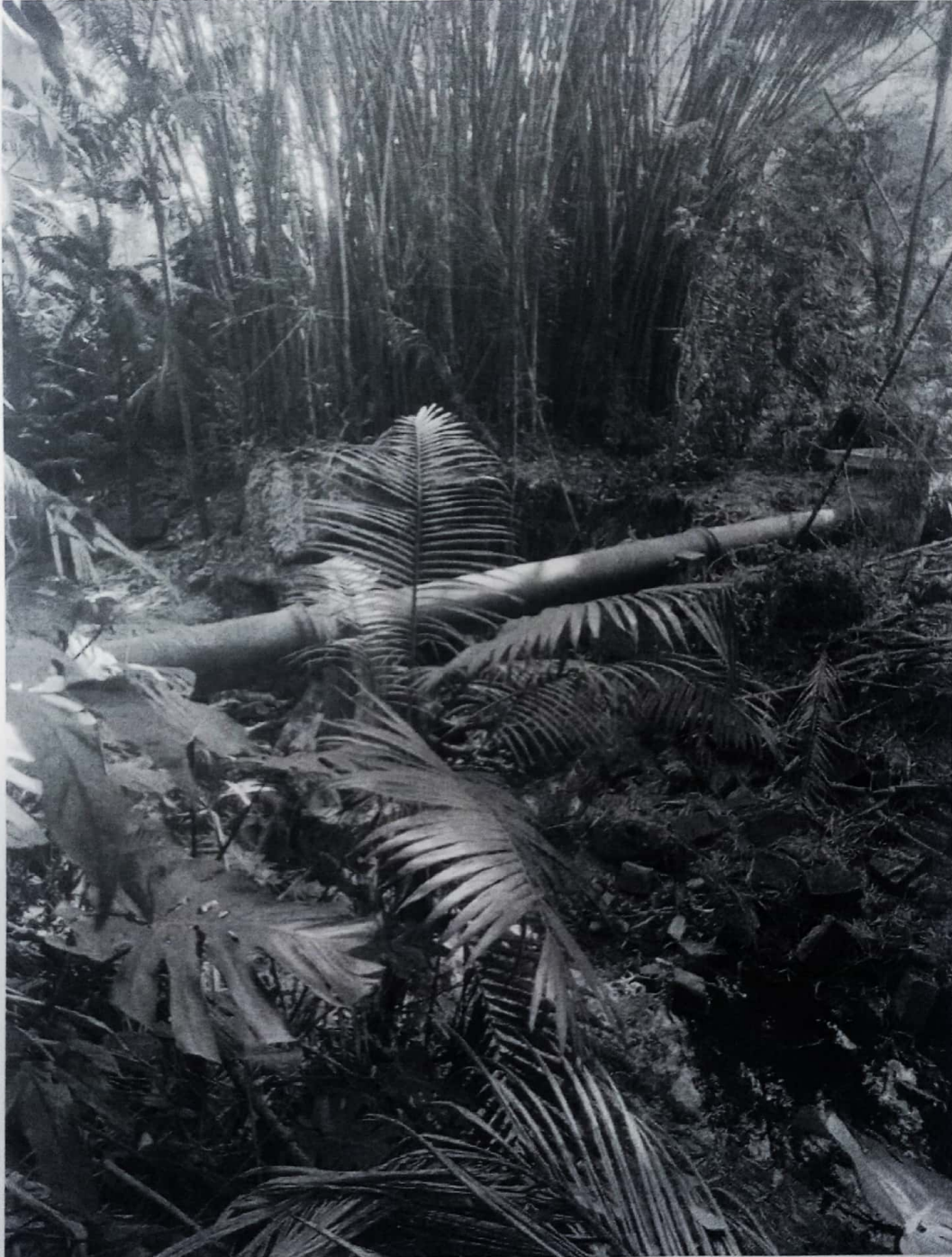
Foto 7: Erosão margem direita do córrego
