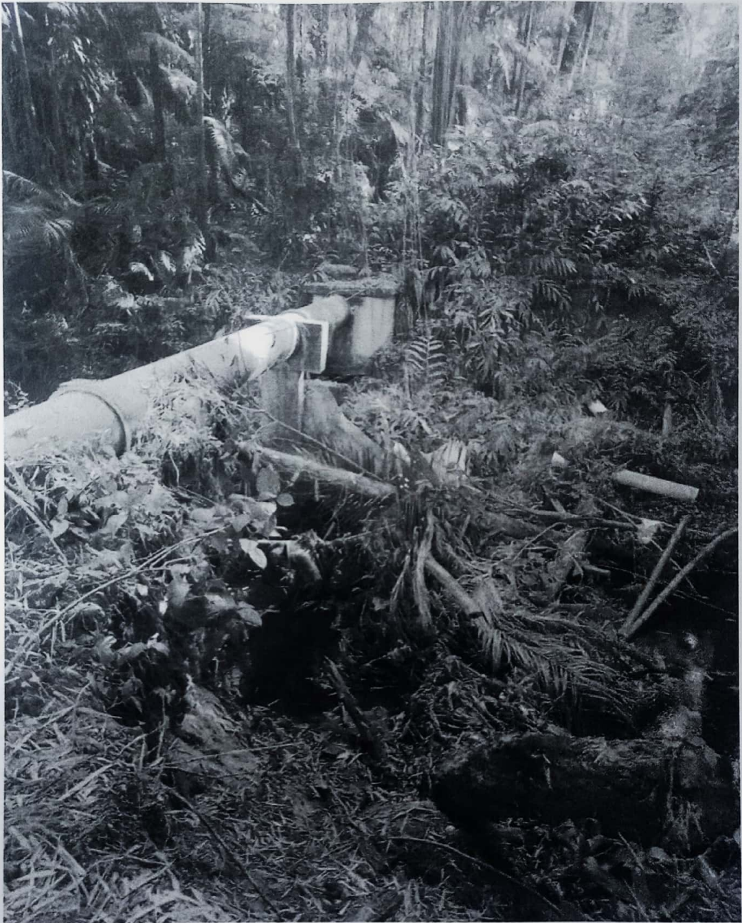
Foto 6: Visão geral da tubulação de esgoto
