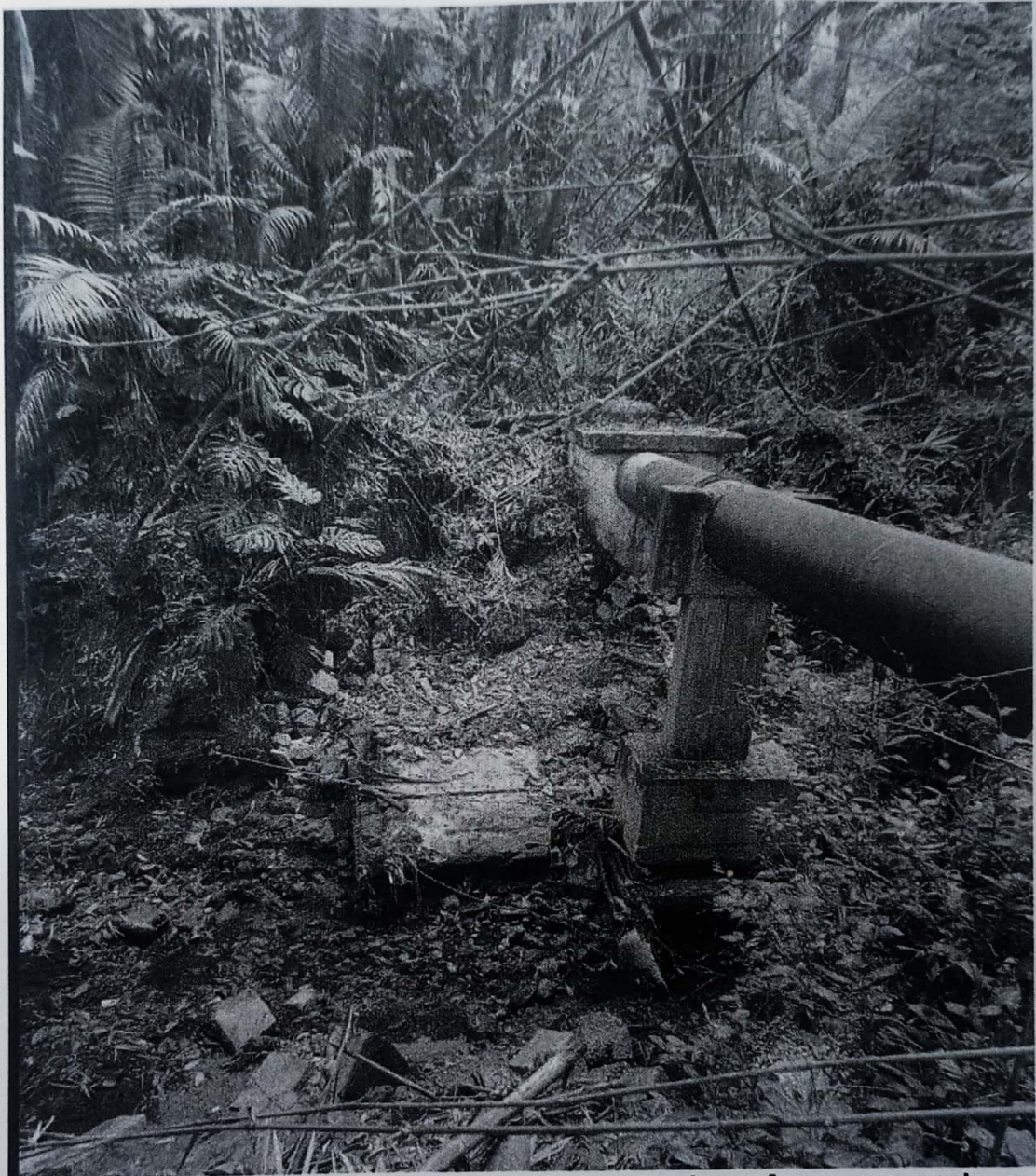
Foto 3: Após quebra do muro que, apoiado na coluna, formava a cunha e causava o redemoinho
