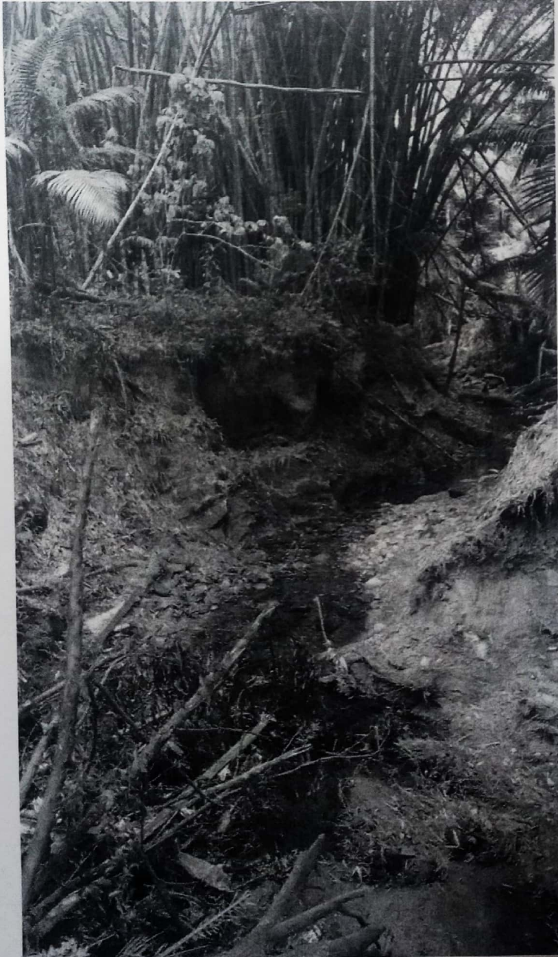
Foto 10: Erosão margem esquerda do córrego
