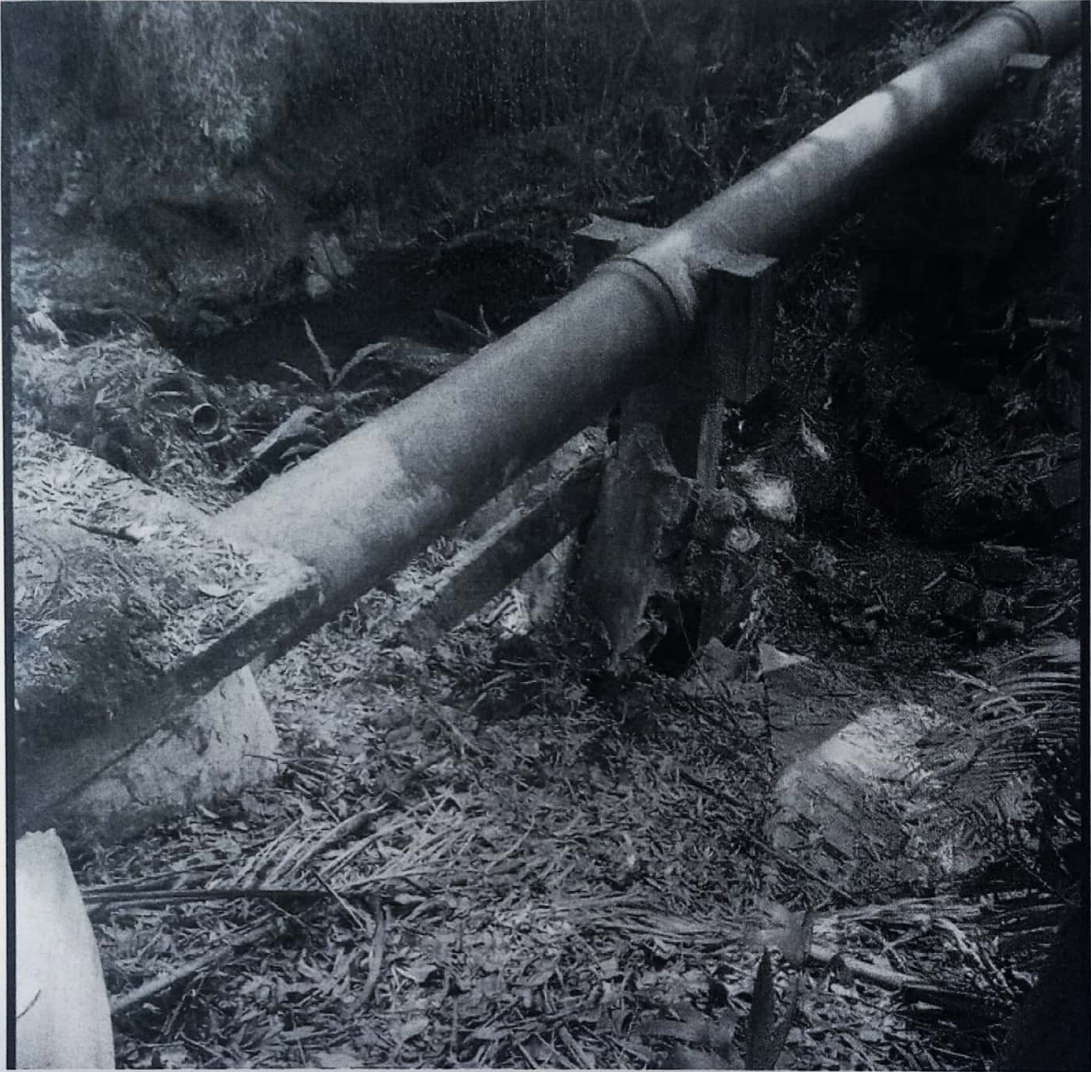
Foto 1: Antes da quebra do muro onde é possível ver o solapamento embaixo do poço de visitaç o
