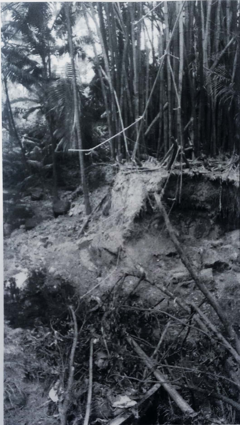
Foto 9: Erosão margem direita do córrego
