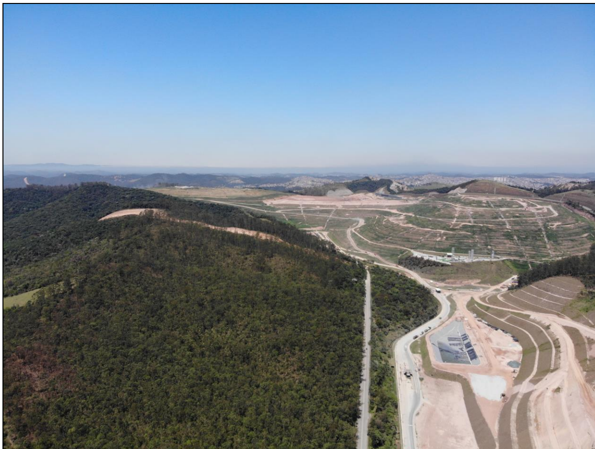
PNM Cabeceiras do Aricanduva (à esquerda) e Centro de Tratamento de Resíduos Leste (à direita)
