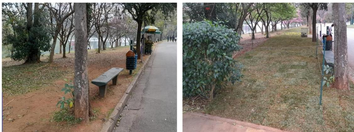
Figura 65: Áreas de descompactação de solo exposto e plantio de grama (antes e depois).
