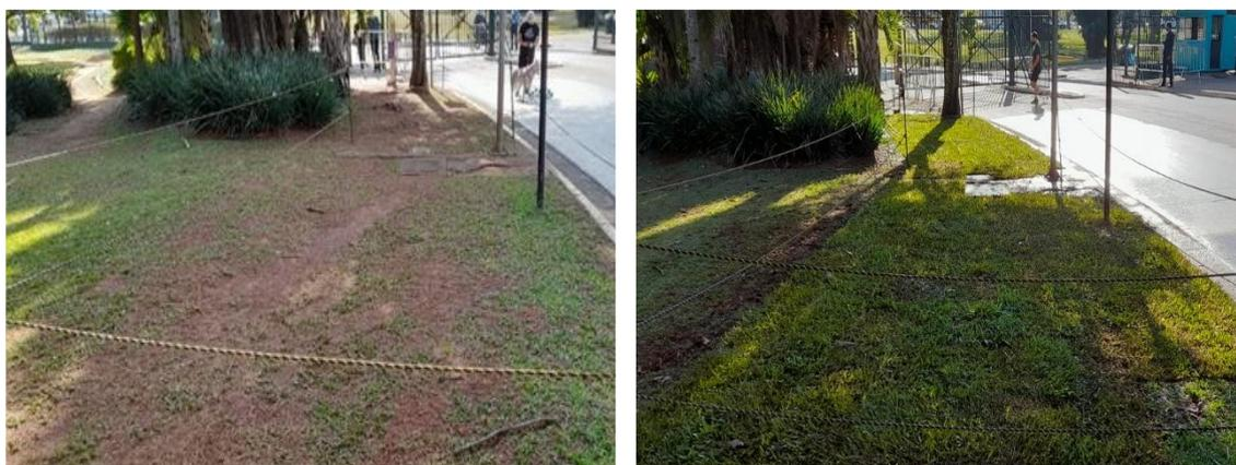
Figura 69: Áreas de descompactação de solo exposto e plantio de grama (antes e depois).
