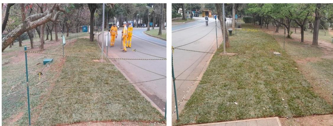
Figura 66: Áreas de descompactação de solo exposto e plantio de grama.
