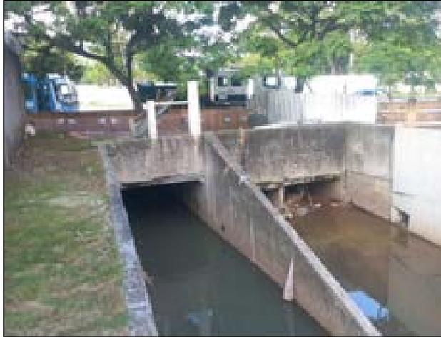
**Foto 9.2.3.1.6.2-5** – Detalhe do Córrego Pedreiras canalizado sob a via de implantação do Corredor Sabará.
