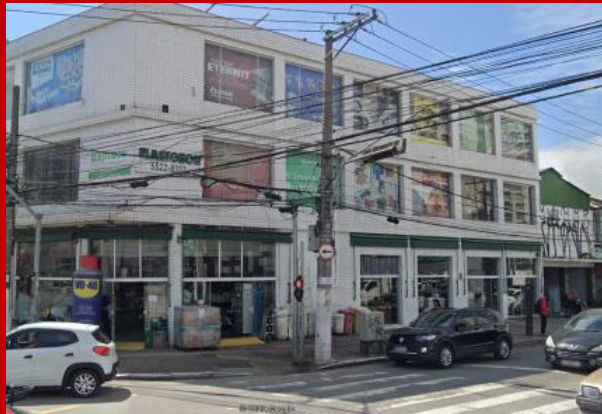
FIGURA 64: TRECHO DE DESAPROPRIAÇÃO COMERCIAL. RUA CRISTALINO COM AV. VICTOR MANZINI
