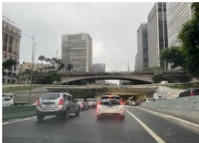
FIGURA 15: CORREDOR NORTE-SUL EM TRECHO QUE APRESENTA OCORRÊNCIA DE ALAGAMENTOS
