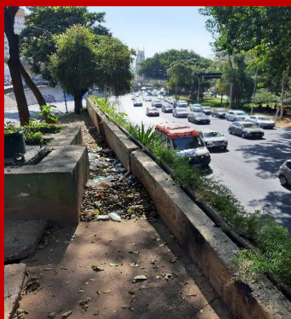
FIGURA 42: CANTEIRO ARBORIZADO PRESENTE NA AV. 23 DE MAIO
