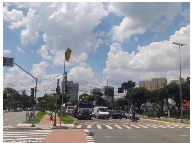
FIGURA 62: CRUZAMENTO DA AV. INTERLAGOS COM A AV. MIGUEL YUNES, SOBRE GALERIA SUBTERRÂNEA DO CÓRREGO OLARIA, NA ADA CORREDOR MIGUEL YUNES
