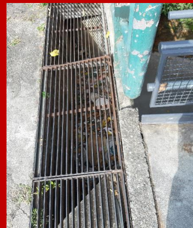
FIGURA 41: CANALETA DE ESCOAMENTO DE ÁGUA NAS IMEDIAÇÕES DO TERMINAL BANDEIRA
