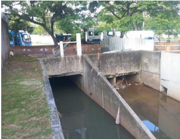
FIGURA 59: DETALHE DO CÓRREGO PEDREIRAS CANALIZADO SOB A VIA DE IMPLANTAÇÃO DO CORREDOR SABARÁ
