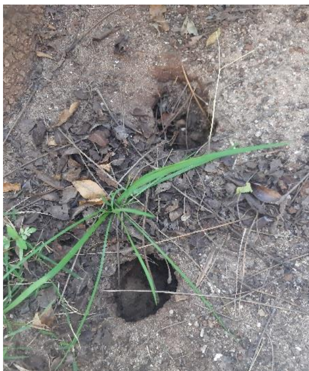
FIGURA 51: DETALHE DE TOCAS DE ROEDORES OBSERVADAS NA PRAÇA ANDREA DORIA, NO LOCAL DE IMPLANTAÇÃO DO CORREDOR SABARÁ
