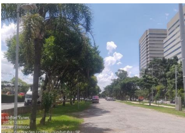
FIGURA 27: FAIXA DE ÁRVORES ISOLADAS PRESENTES NO CANTEIRO CENTRAL DA AV. MIGUEL YUNES -CORREDOR MIGUEL YUNES.
