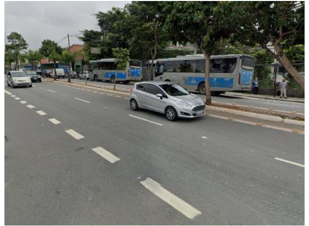
FIGURA 60: AV. NOSSA SENHORA DO SABARÁ, NO LOCAL DO CÓRREGO CAMPO GRANDE, INDICANDO AUSÊNCIA DE CURSO D'ÁGUA
