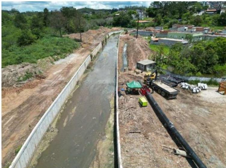
Execução de solda nos tubos do coletor a serem instalados por método não destrutivo
