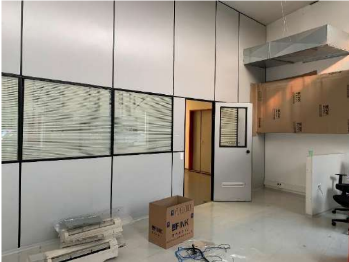
Divisórias e instalações. Fonte: Foto do levantamento, 2024.
