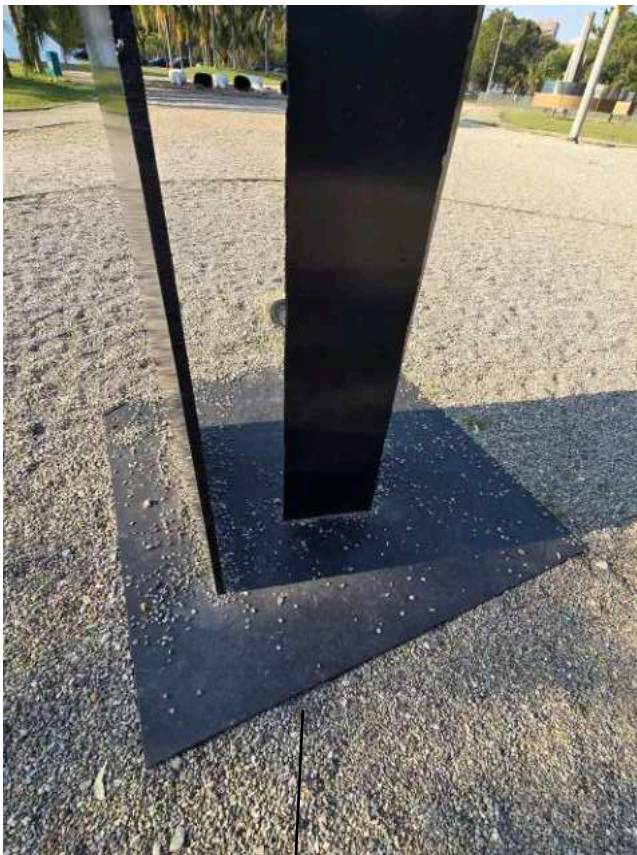
pontos de oxidação generalizados
