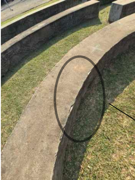
perda de material (principalmente nas bordas)
