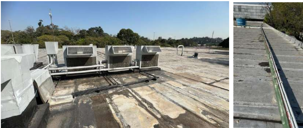
Unidades condensadoras, tomada de ar, caixas d'água e tubulações serão retiradas devido a reforma da marquise
