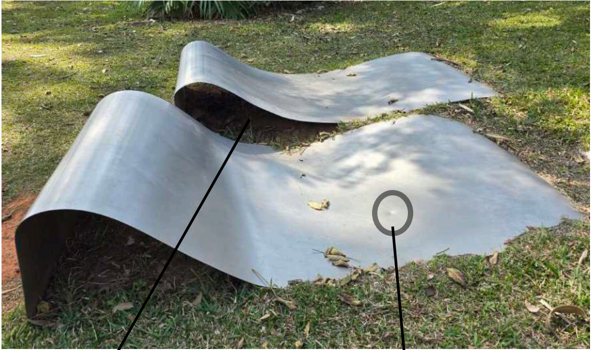
deformação/ afundamento
