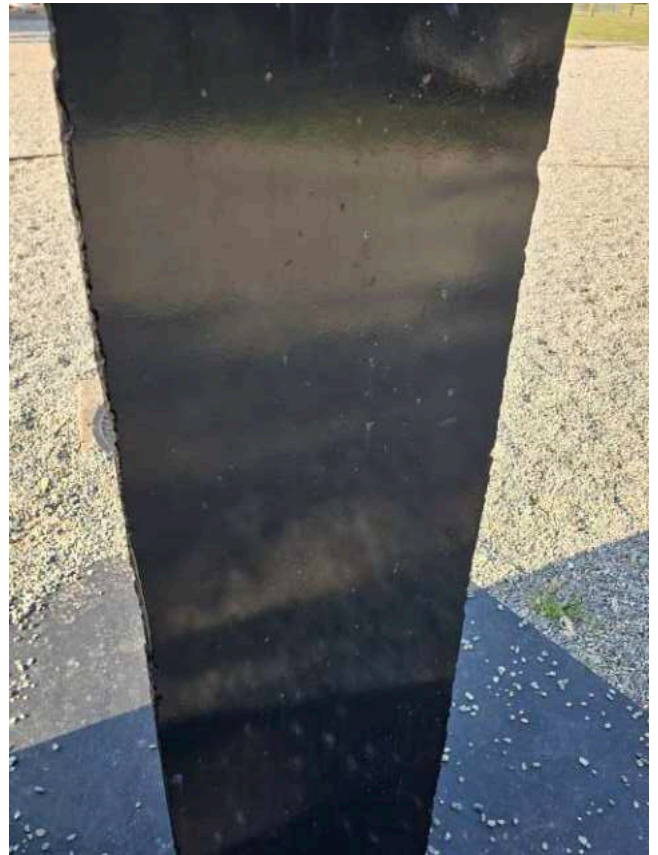
pontos de oxidação generalizados
