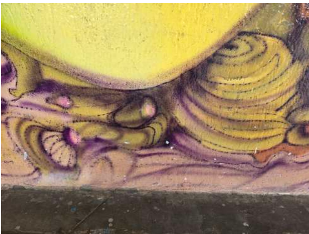
diversos pontos com perda de suporte
