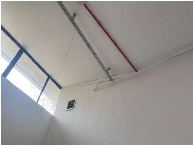
Instalações aparentes. Fonte: Foto do levantamento, 2024.
