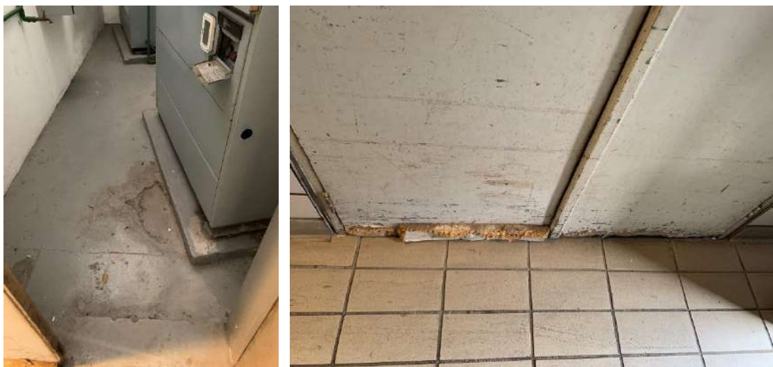
Piso e porta da Casa de Máquinas. Fonte: Fotos do levantamento, 2024.
