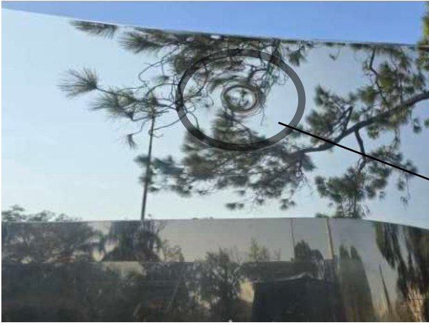
Presença de diversos pontos de afundamento
