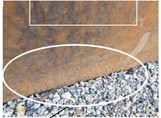
diversos pontos de corrosão e desgastes
