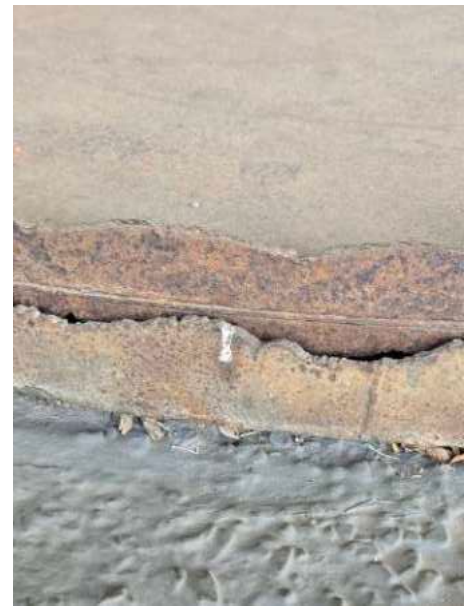
bordas com maior presença de corrosão
