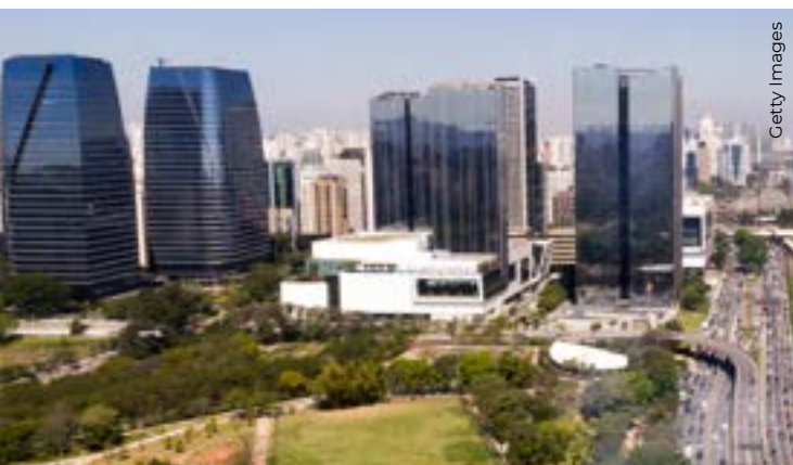
Padrão de prédios que geram impacto a fauna por colisão em superfícies reflexivas
