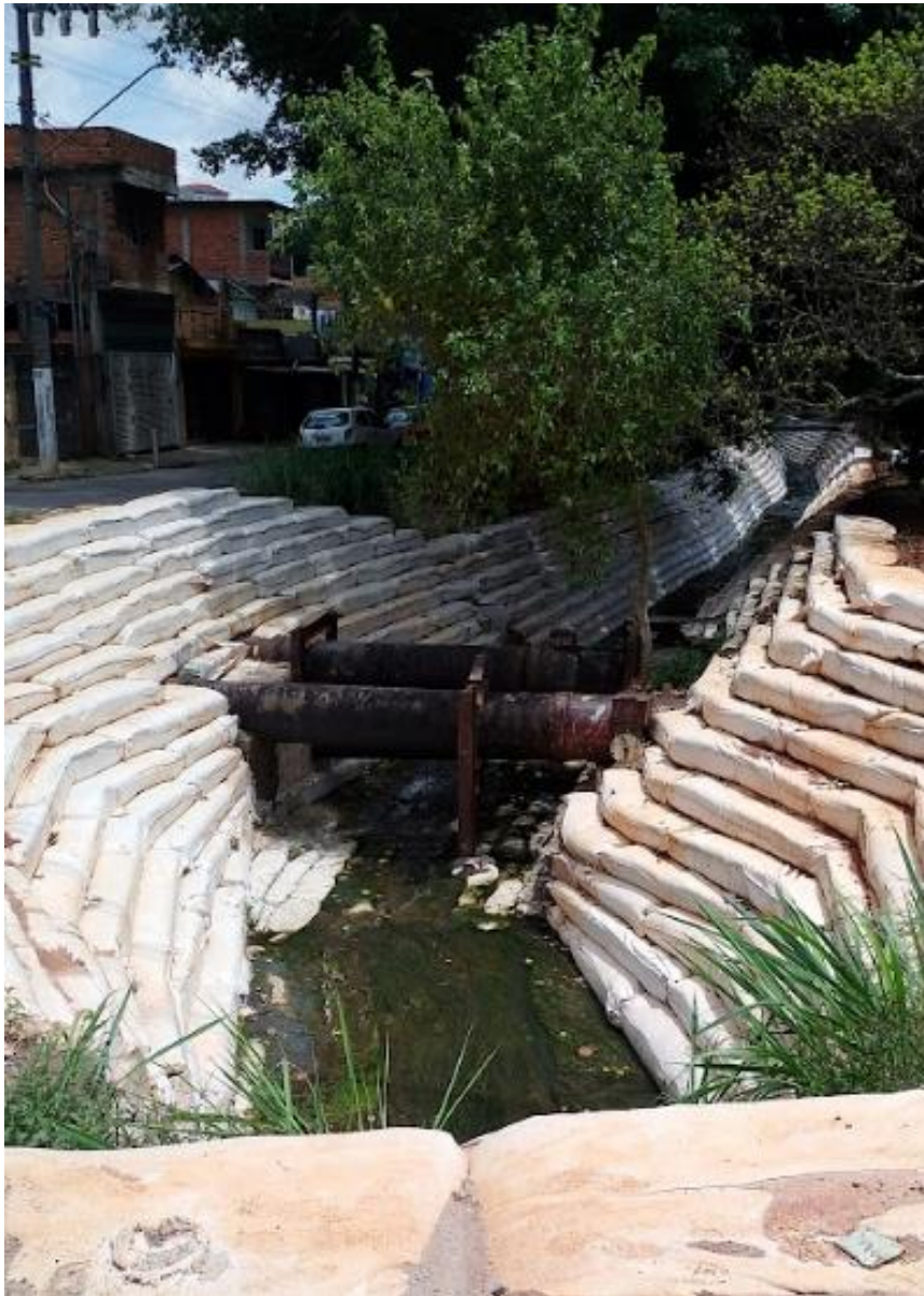
Figura 6 - Obras de canalização do Córrego Água Podre
