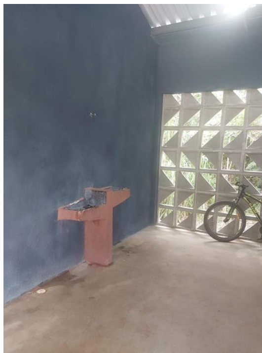
Figura 22 – Registro do bebedouro existente
