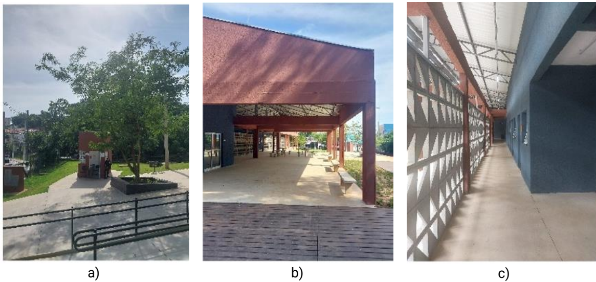
Figura 23 – Visuais da portaria e edificação principal, e seus elementos vazados marcantes
