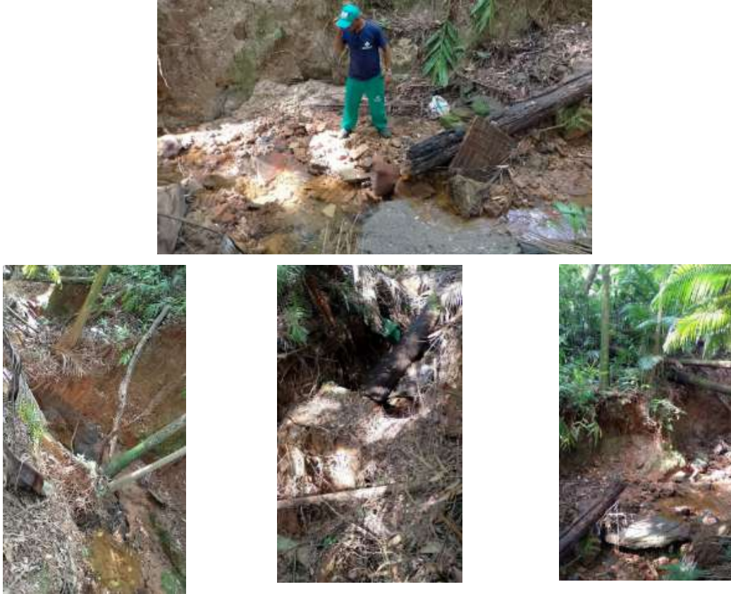
Figura 13– Áreas com erosão no entorno da nascente e nas margens do córrego
