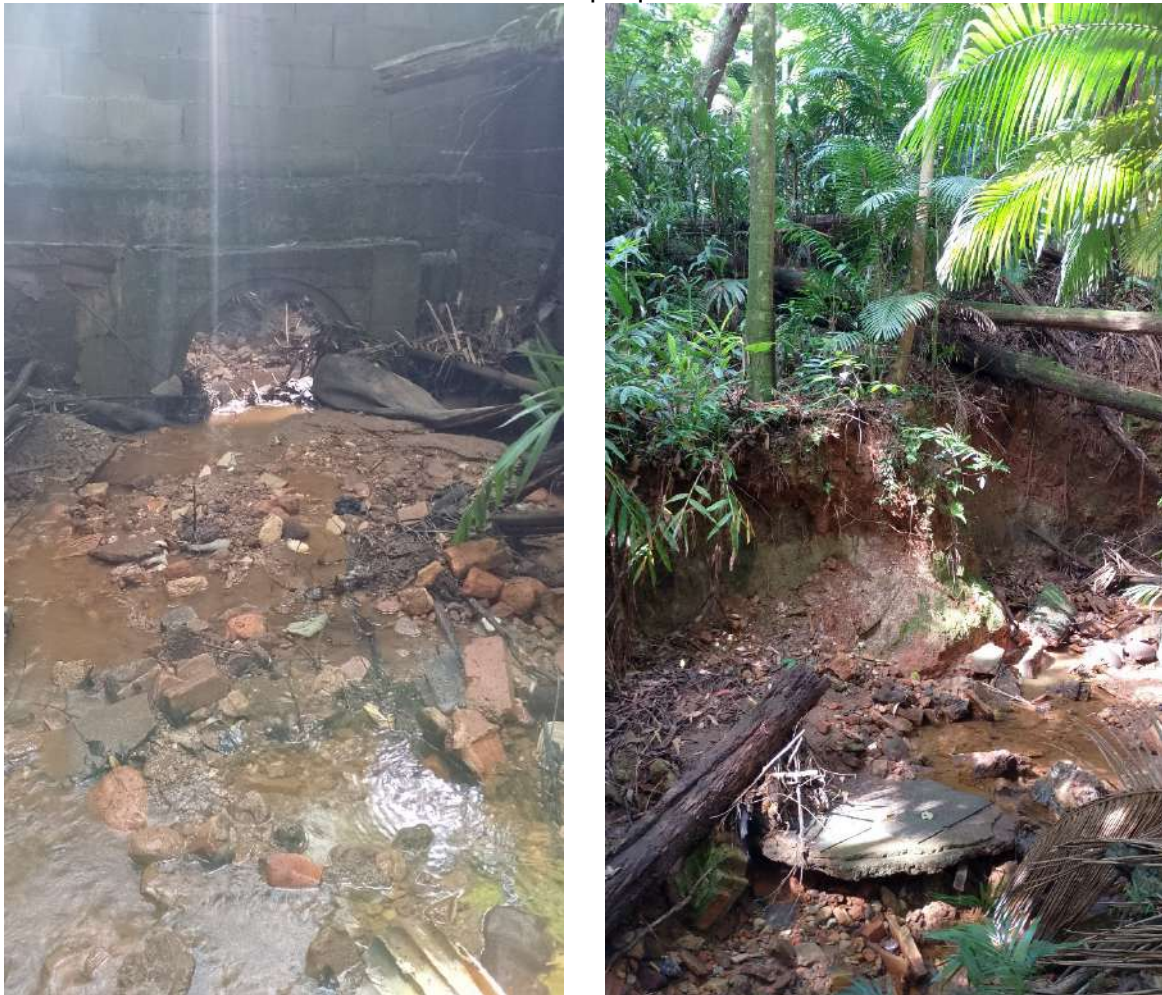
Figura 16 – Margens do Córrego Poli com erosão, leito com entulho e manilha por onde o Córrego sai do parque
