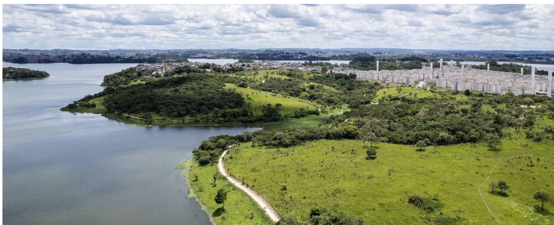
Figura 3 - Vista geral da área do Parque dos Búfalos no Jardim Apura
