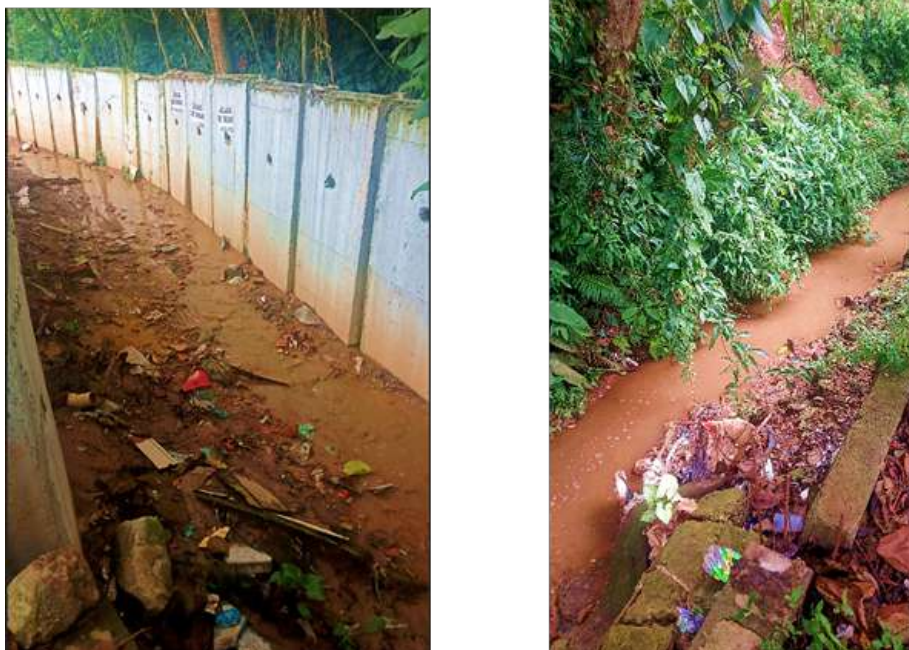
Figura 12 - Parte canalizada e não canalizada do córrego a leste do parque
