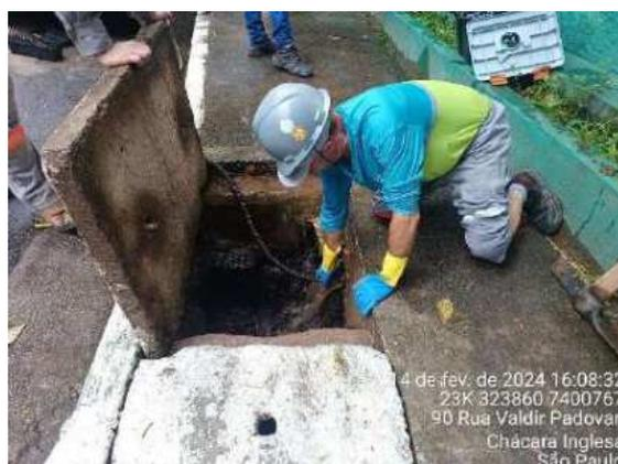
**Figura 989: Limpeza de manutenção das caixas hidráulicas - antes**
