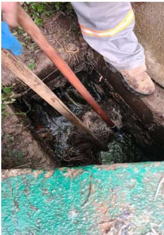
**Figura 990: Limpeza de manutenção das caixas hidráulicas**
