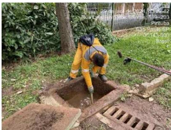
**Figura 977: Limpeza de manutenção das caixas hidráulicas - depois**
