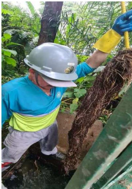
**Figura 991: Limpeza de manutenção das caixas hidráulicas**
