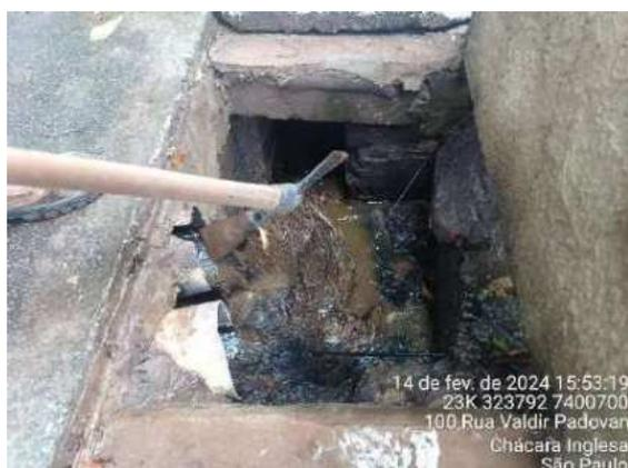
**Figura 988: Limpeza de manutenção das caixas hidráulicas**
