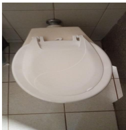
Figura 204 Substituição de itens quebrados - Depois
