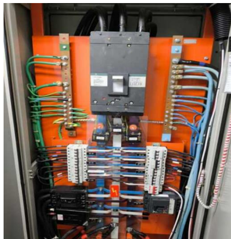
Figura 180 Manutenção nos quadros elétricos
