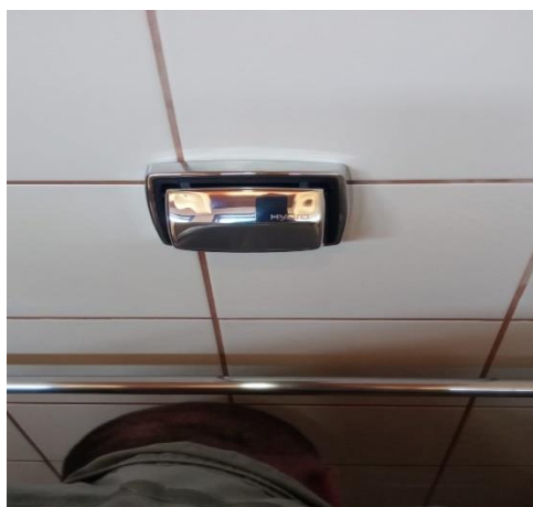
Figura 202 Substituição de Torneira
