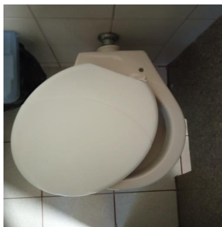
Figura 203 Substituição de itens quebrados - Antes
