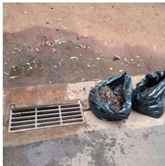
Figura 182 Limpeza de bocas de lobo
