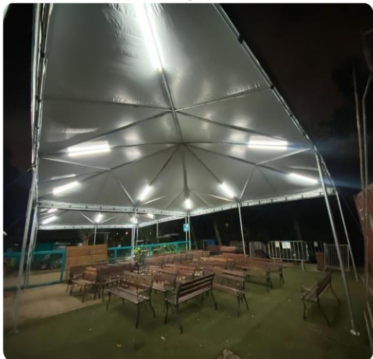
Figura 179 Instalação de luminárias na área operacional.
