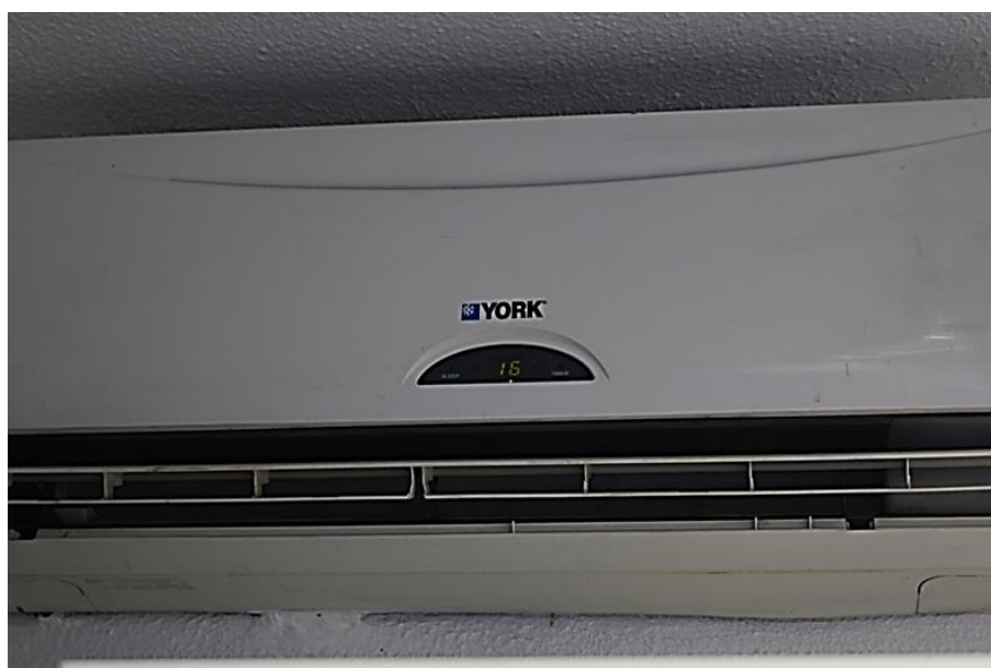
Figura 46 Aparelho de ar-condicionado novo instalado na sala A
