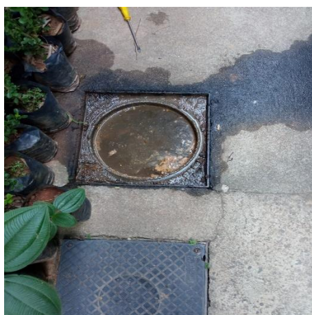
Figura 205 Desobstrução de redes - Antes
