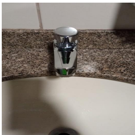
Figura 201 Substituição de Torneira
