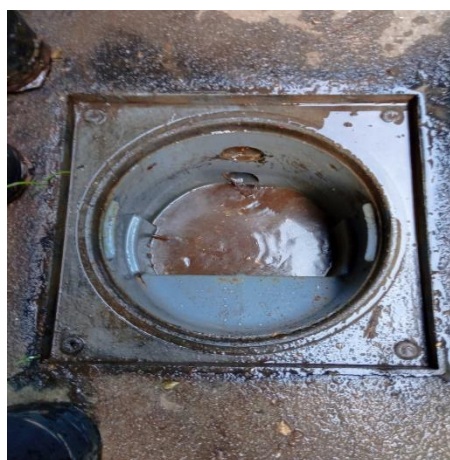
Figura 206 Desobstrução de redes - Depois
