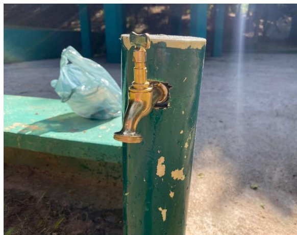
Figura 155. Após a troca de torneira
