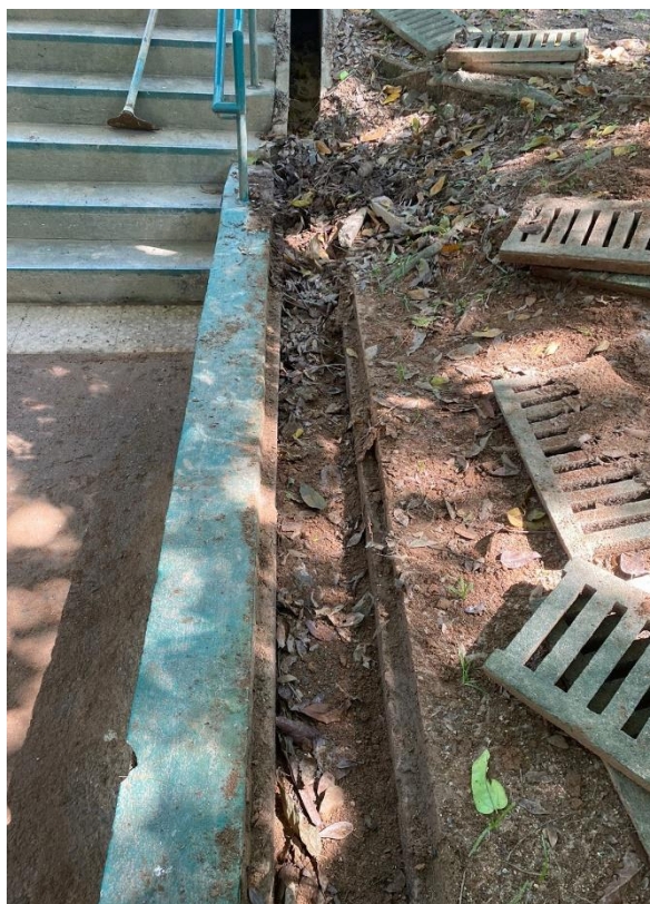
Figura 152. Durante a limpeza de canaletas
