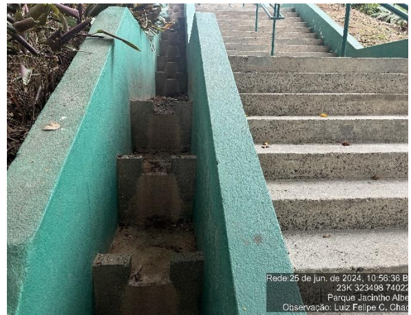
Figura 65. Após a limpeza de canaletas
