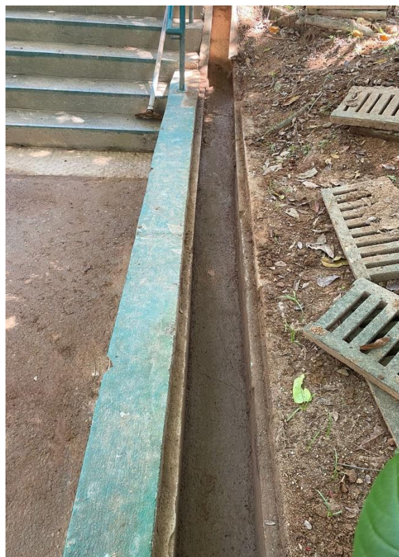
Figura 153. Durante a limpeza de canaletas
