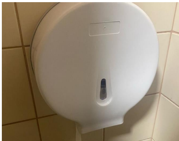
Figura 154. Após a troca de papeleira em banheiro
