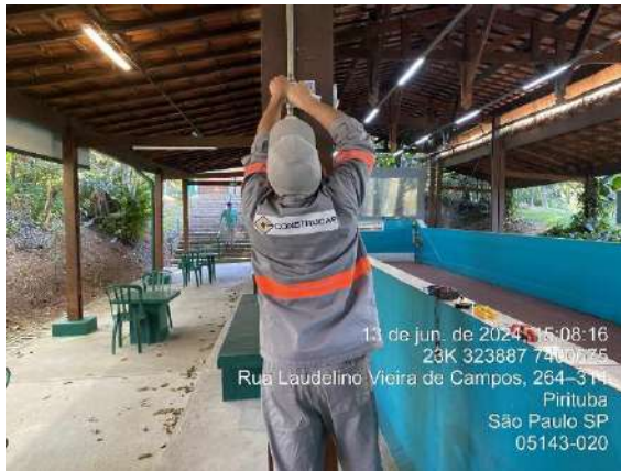
Figura 323: Instalação de aviso audiovisual no banheiro acessível
