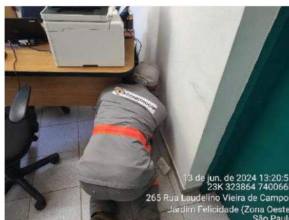
Figura 318: Manutenção de substituição de tomadas na administração
