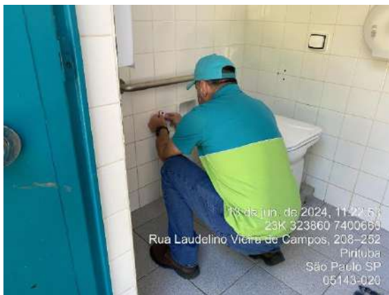
Figura 323: Instalação de aviso audiovisual no banheiro acessível
