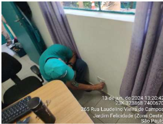
Figura 321: Manutenção de substituição de tomadas do bocha
