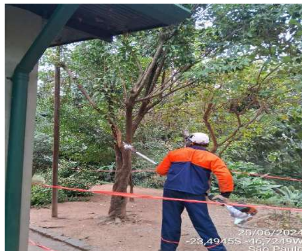
Figura 196: Atividade de poda próximo a administração
