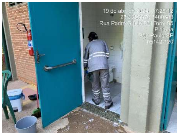
Figura 229: Limpeza de manutenção das vias internas - antes
