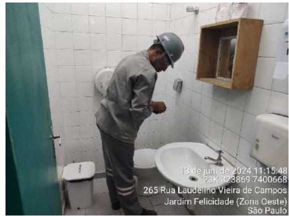
Figura 322: Manutenção de substituição de tomadas do bocha
