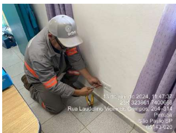
Figura 317: Manutenção de substituição de tomadas na administração
